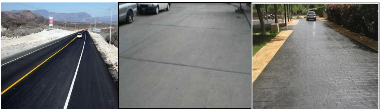
Gráfico 3. Clasificación de Pavimento flexible (izq.), rígido (centro) y mixto (der)
