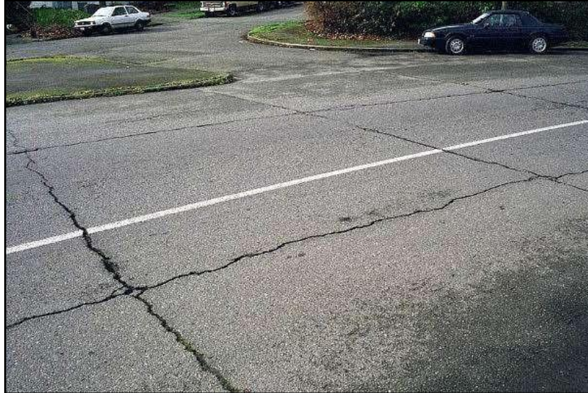
Gráfico 13. Fisura de reflexión de junta.
