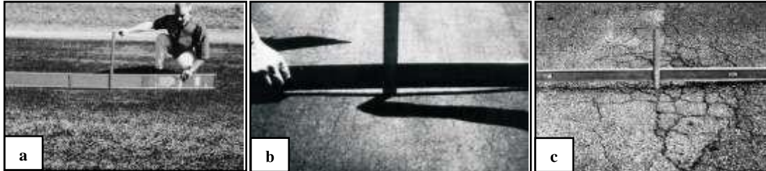
Gráfico 34. Depresión de nivel de severidad bajo (a), medio (b) y alto (c).
