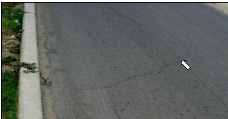
Gráfico 22. Fisura parabólica
