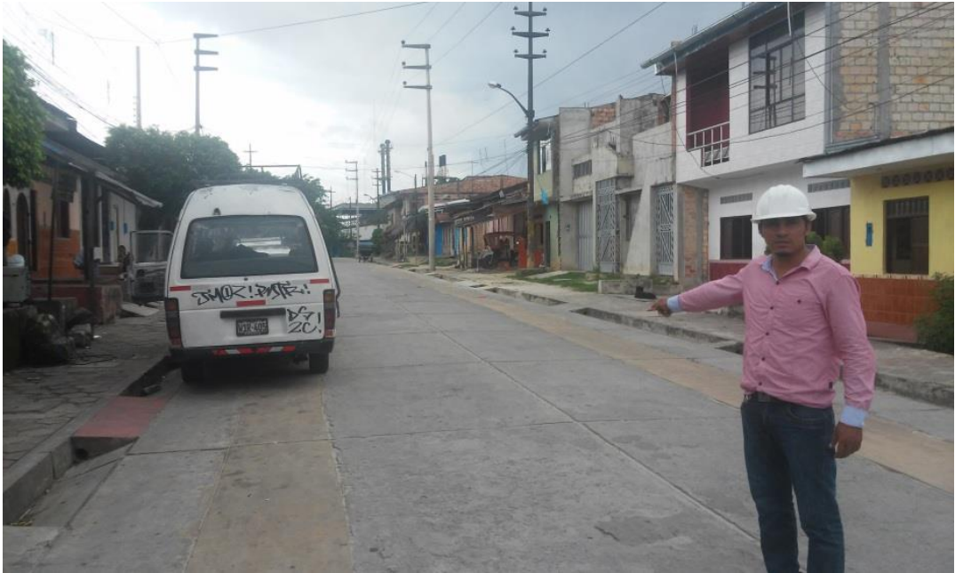
Figura 185. Foto panorámica de la calle Piura cuadra 6.
