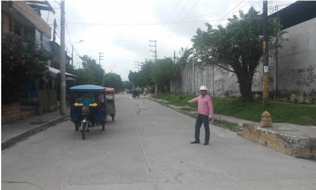
Figura 175. Foto panorámica de la calle Piura cuadra 4.
