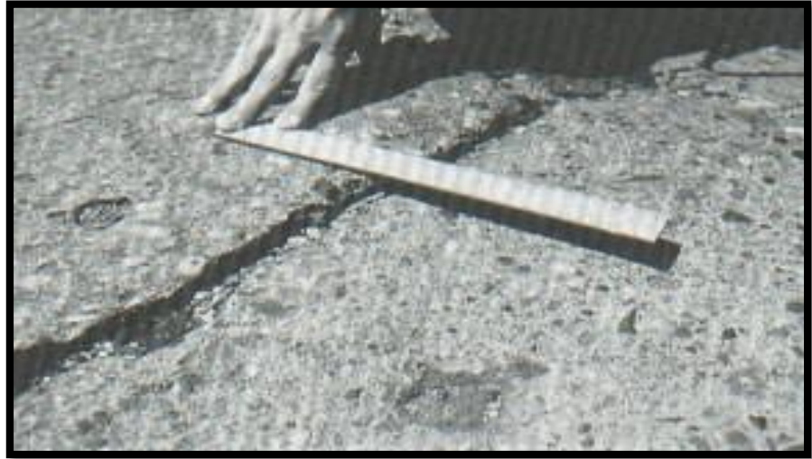
Figura 22. Escala de severidad media.
