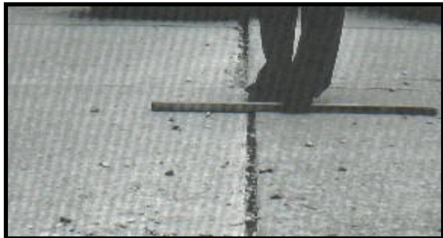
Figura 21. Escala de baja severidad.
