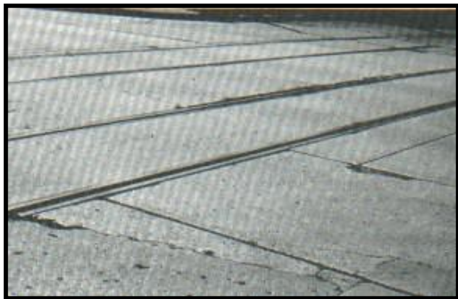
Figura 46. Cruce de vía férrea de baja severidad.
