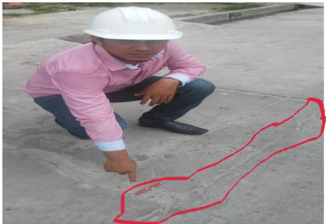
Figura 184. Calle, Piura cuadra 5, se observa Grita lineal de baja severidad.
