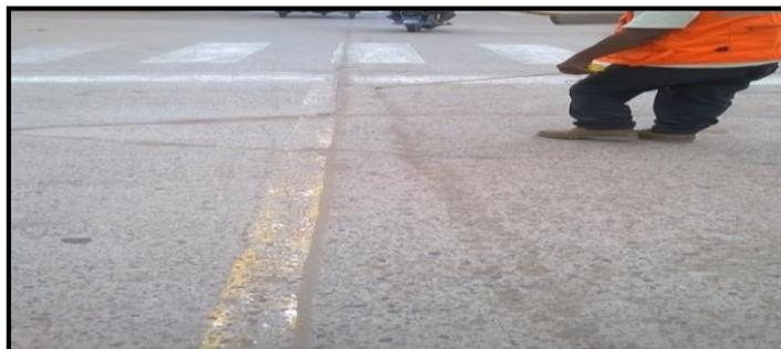
*Figura 13:* Pulimento de agregados.
