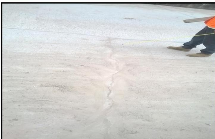
**Figura 10:** Grieta lineal transversal de media severidad.
