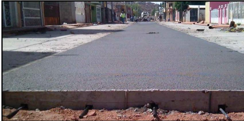
*Figura 12:* Construcción de losa con refuerzo.
