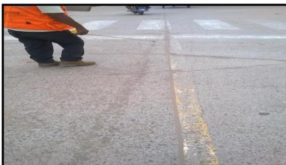
*Figura 19:* Sello de junta de baja severidad.
