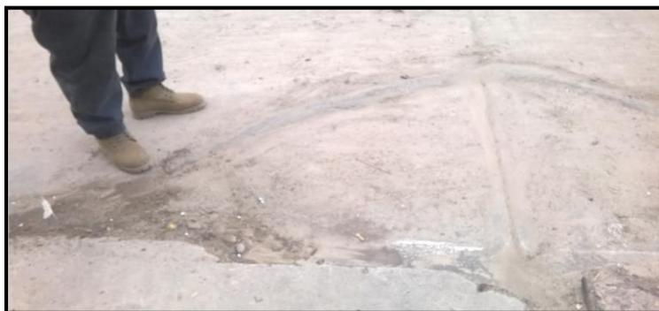
**Figura 15:** Descascaramiento de esquina de severidad media.
