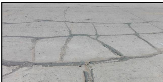
*Figura 17:* Losa dividida de nivel de severidad alta.
