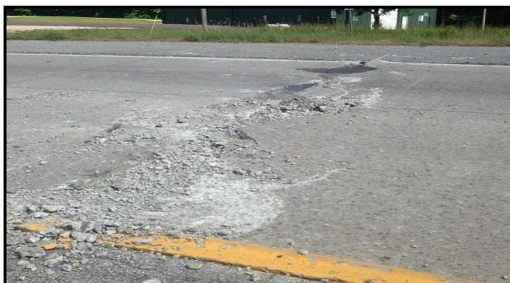
**Figura 16:** Blowup – Buckling de severidad media.
