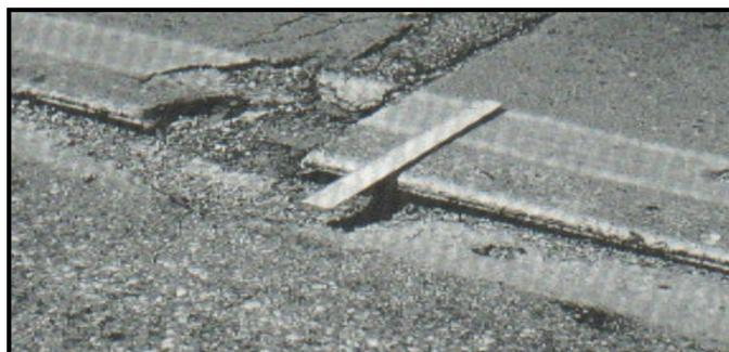
*Figura 20:* Daño desnivel carril/berma de baja severidad.
