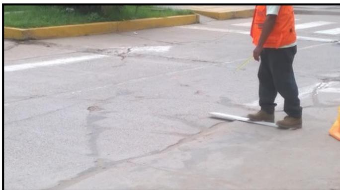
**Figura 18:** Escala de nivel de severidad alta.
