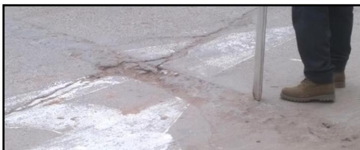
*Figura 24:* Punzonamiento de nivel de severidad media.
