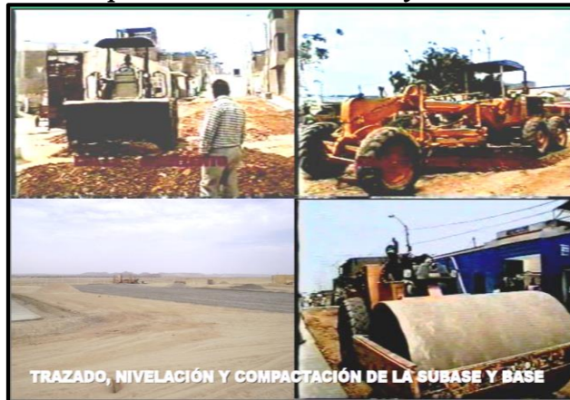
Grafico 06 Preparación de la Sub-base y/o base
