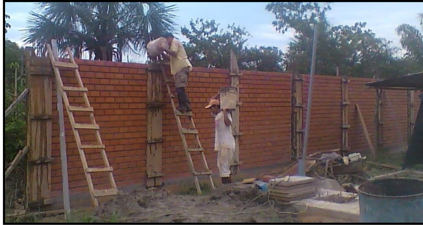
Figura 05: Llenado de concreto en las columnas
