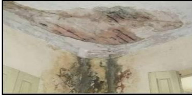
Figura 31: Deterioro por medio de carbonatación.
