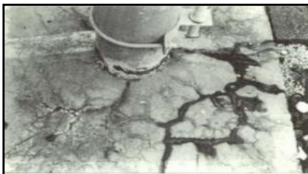
Figura 30: Deterioro por ataque de sulfatos.
