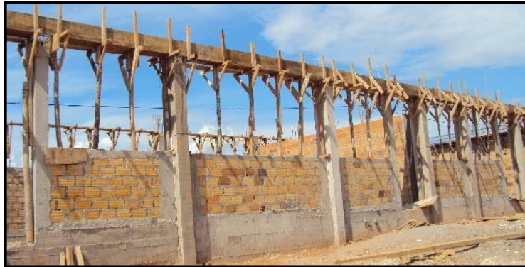
Figura 21: Detalle de encofrado de viga de amarre.
