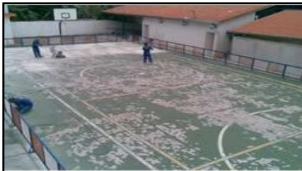
Figura 33: Deterioro mediante la abrasión.
