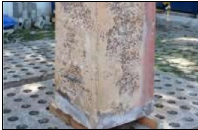
Figura 34: Deterioro por acción de fuego.
