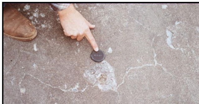
Figura 44: Popouts o cráter en el concreto.
