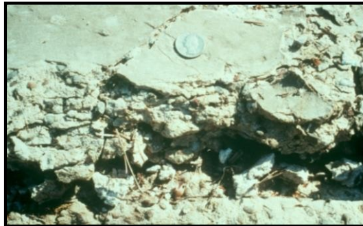
Figura 45: Desintegración de una estructura.
