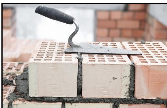
Figura 24: Detalle del empastado con mortero y ladrillo.
