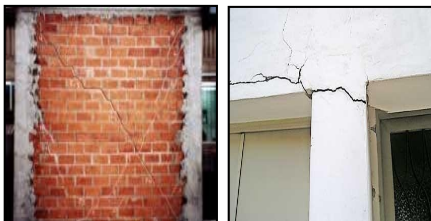
Figura 37: Fisuración de elementos estructurales.
