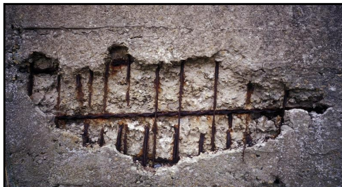
Figura 29: Ataques por cloruros.
