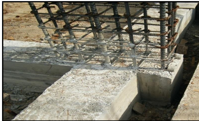
Figura 18: Viga de cimentación en una edificación.
