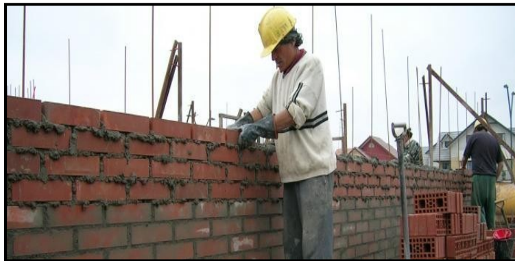
Figura 25: Muro de albañilería armado.
