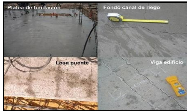
Figura 35: Patologías por contracción de secado.
