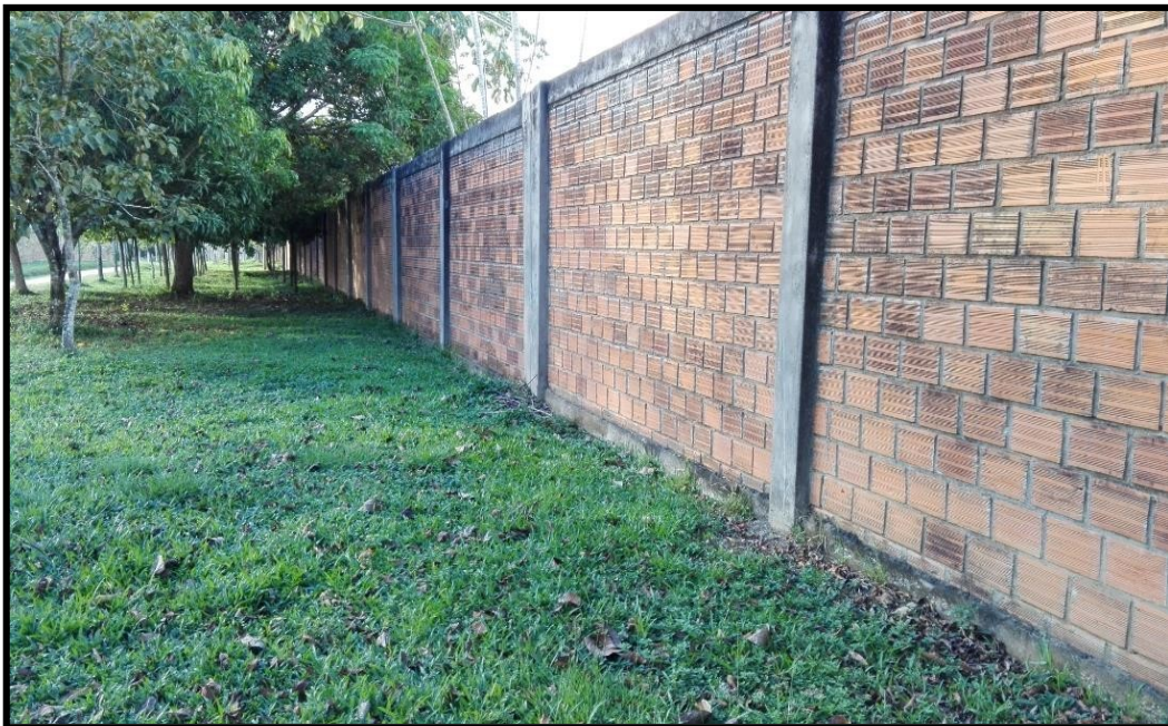
Figura 87: Vista panorámica interior del cerco perimétrico del Instituto de Investigaciones de la Amazonía Peruana.
