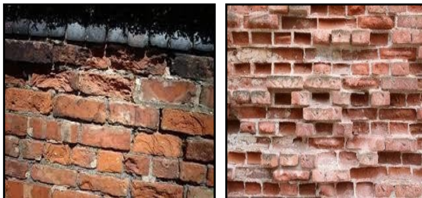
Figura 36: Erosión en muros de albañilería.
