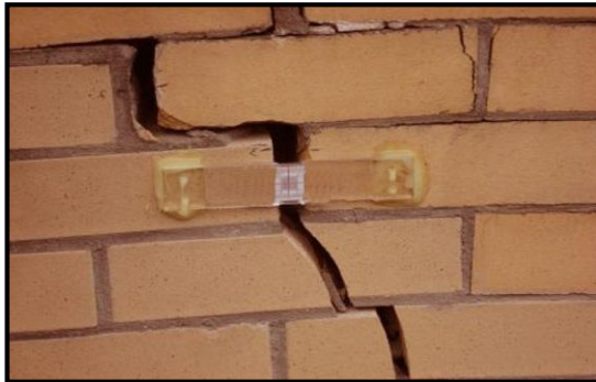
Figura 32: Patologías de grietas estructurales.
