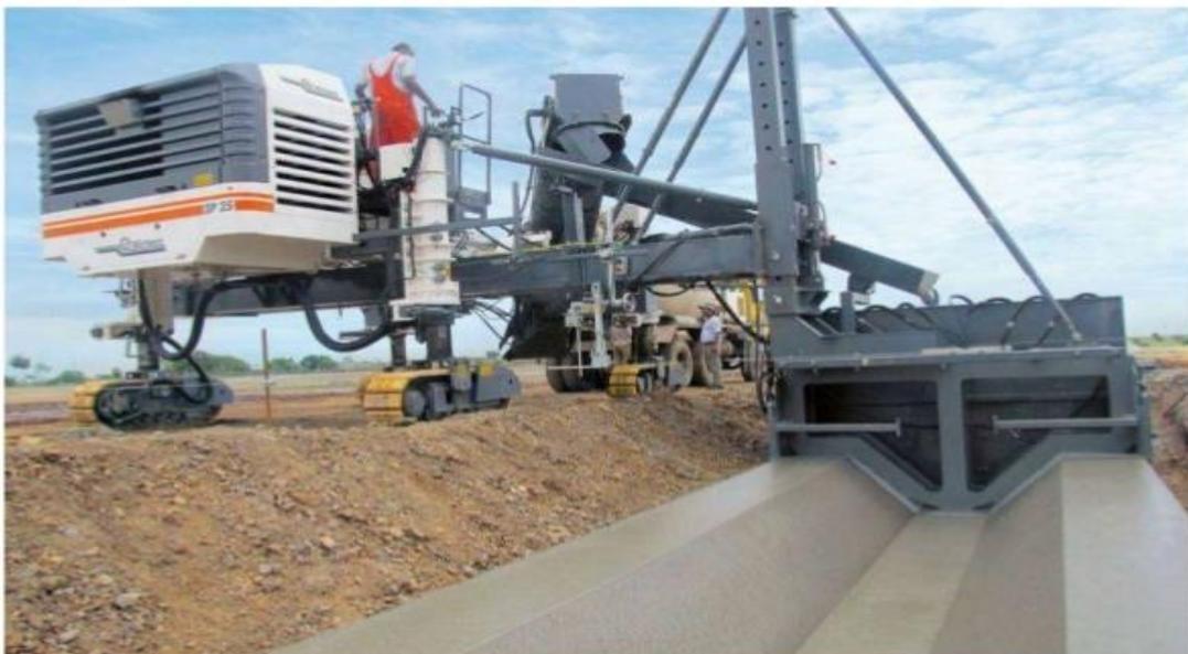
Figura N° 3: Maquina revistiendo canal de concreto.
