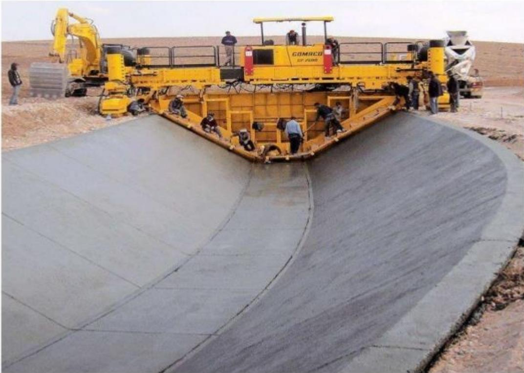
Figura N° 2: Maquina especializada en revestimiento de canales de concreto.
