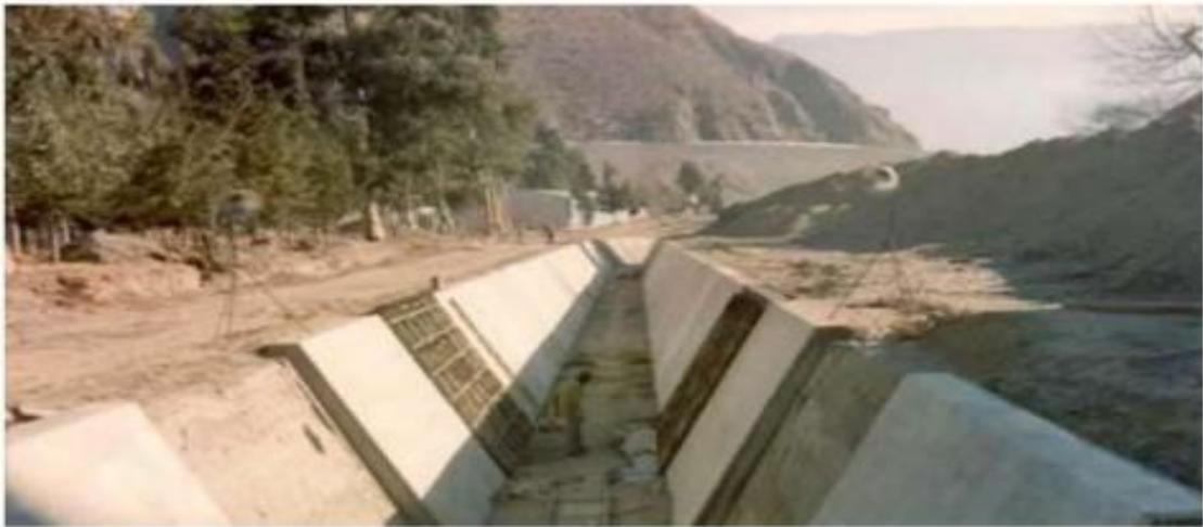
Figura N° 1: Revestimiento de Canal Trapezoidal
