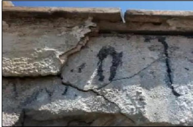
**Figura 21.** Desprendimiento del concreto
