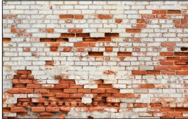
**Figura 18.** Erosión en muro de albañilería
