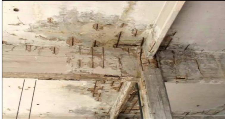
**Figura 16.** Patología en concreto armado
