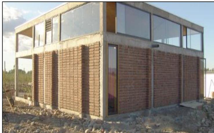
**Figura 4.** Albañilería Confinada
