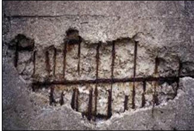
**Figura 22.** Corrosión
