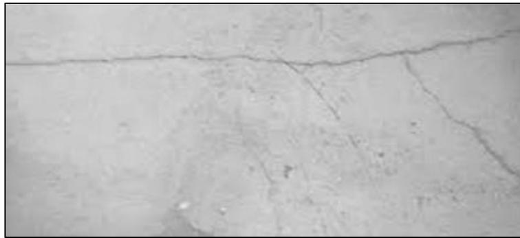
**Figura 19.** Fisura en concreto
