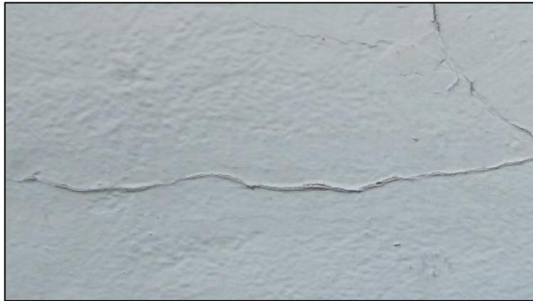
Figura 25. Fisura en muro confinado
