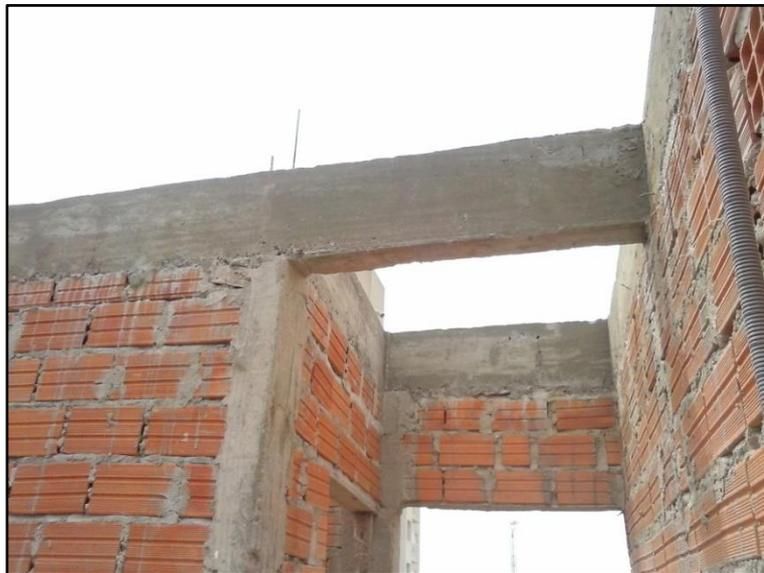
Figura 6.Viga de concreto
