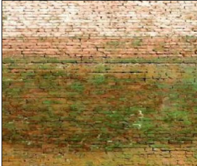
Figura 29. Organismo en muros de albañilería
