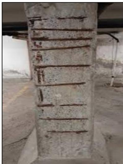
Figura 28.corrosion en columna
