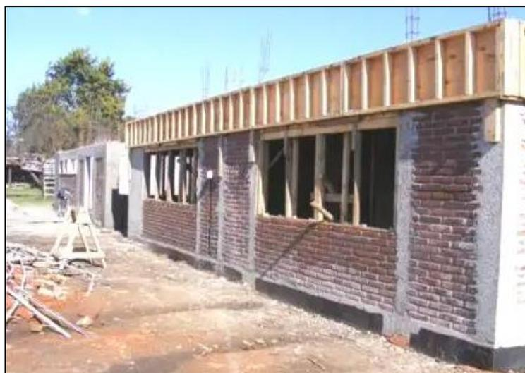
Figura 4. Albañilería Confinada o reforzada
