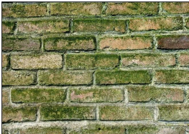
Figura 22. Moho en muro de albañilería
