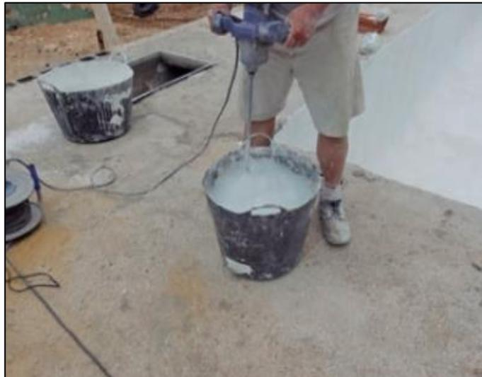
Figura 13. Mortero batido por mezcladora
