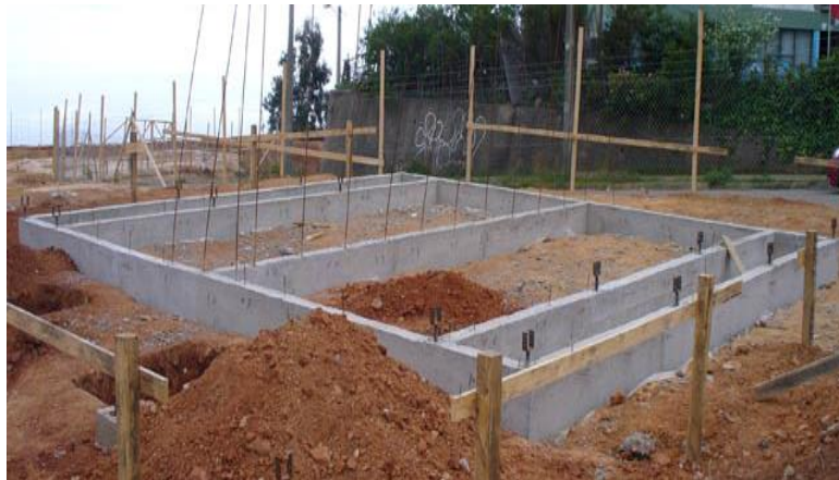
Figura 8. Sobrecimiento Nota. Fuente: (Abanto F. 2007) 12
