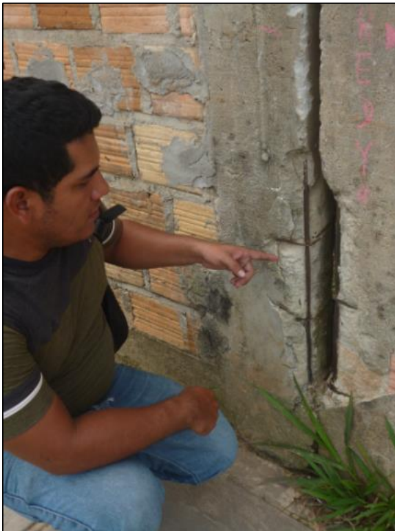
Fotografía 04: Corrosión Identificada en columna del muro confinado, están ubicadas en la UM-08 y UM-04, y tienen un nivel de severidad Moderado y Leve respectivamente.
