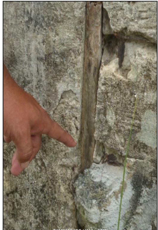
Fotografía 04: Corrosión Identificada en columna del muro confinado, están ubicadas en la UM-08 y UM-04, y tienen un nivel de severidad Moderado y Leve respectivamente.
