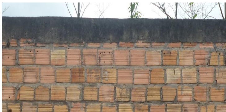
Figura 7. viga solera Nota. Fuente: (Elaboración propia)
