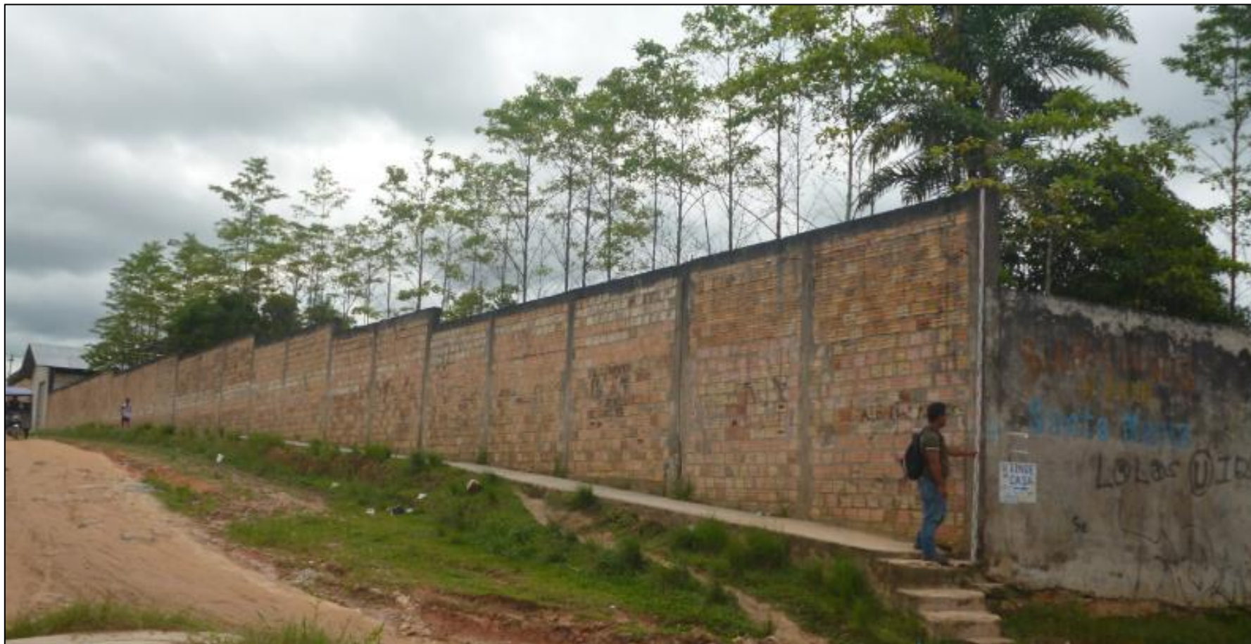
Fotografía 01: Panorámica lado izquierdo
