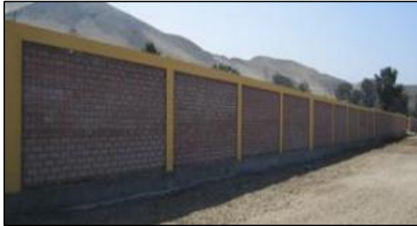
Figura 18. Cerco perimétrico de albañilería Nota. Fuente: (Cabada C. 2016) 15
