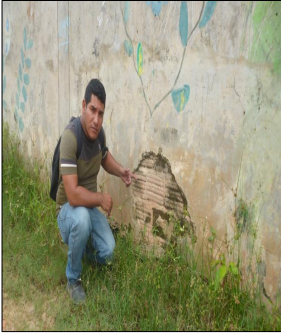
Fotografía 03: Desprendimiento en Muro confinado, que se encuentra en la UM- 19, y tiene un nivel de severidad Leve.
