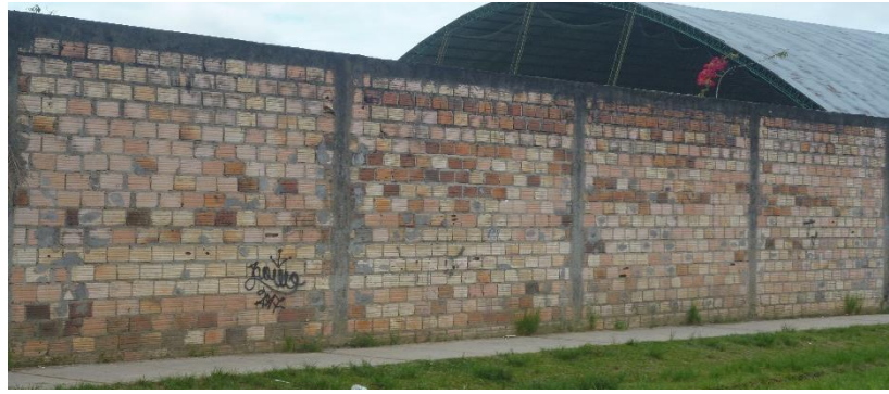
Figura 6. Columnas de amarre Nota. Fuente: (Elaboración propia)
