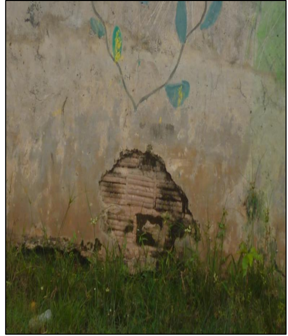
Fotografía 03: Desprendimiento en Muro confinado, que se encuentra en la UM- 19, y tiene un nivel de severidad Leve.
