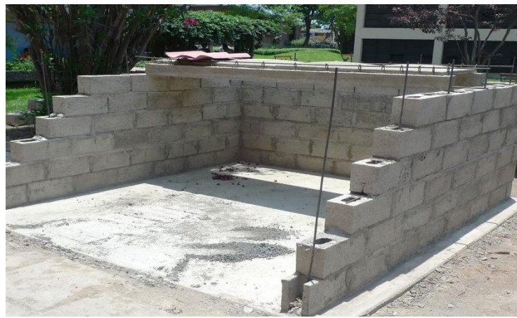
Figura 4. albañilería armada Nota. Fuente: (Guipúzcoa I. 2011) 9
