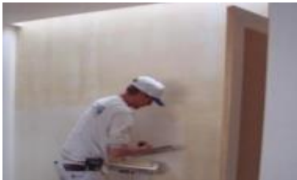
Figura 10. Estucado con mortero Nota. Fuente: (Cabada C. 2016) 14
