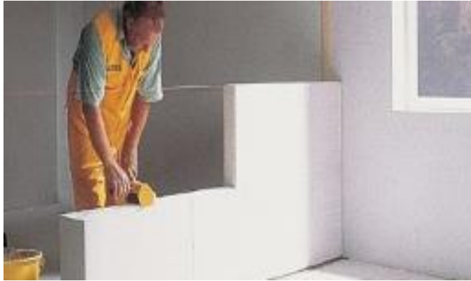
Figura 12. Revestimiento de muro Nota. Fuente: (Cabada C. 2016) 14
