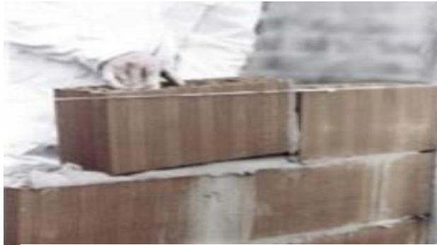
Figura 11. Asentado de ladrillo Nota. Fuente: (Cabada C. 2016) 14
