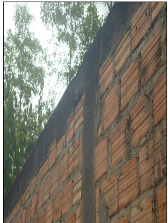
Fotografía 06: Moho Identificado en las vigas de confinamiento, están ubicadas en la UM-02 y UM-11, ambas tienen un nivel de severidad Moderado.
