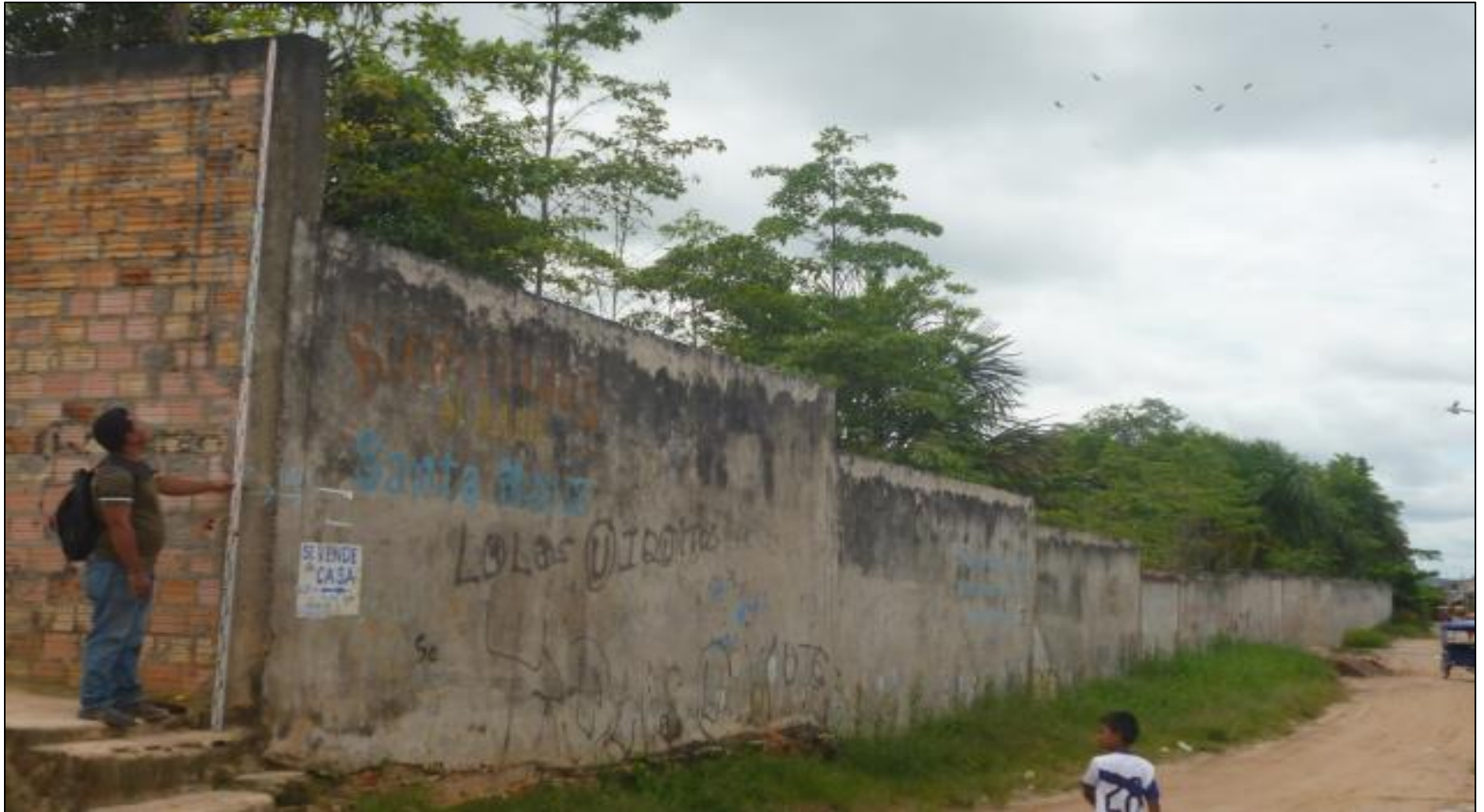
Fotografía 02: Panorámica lado derecho
