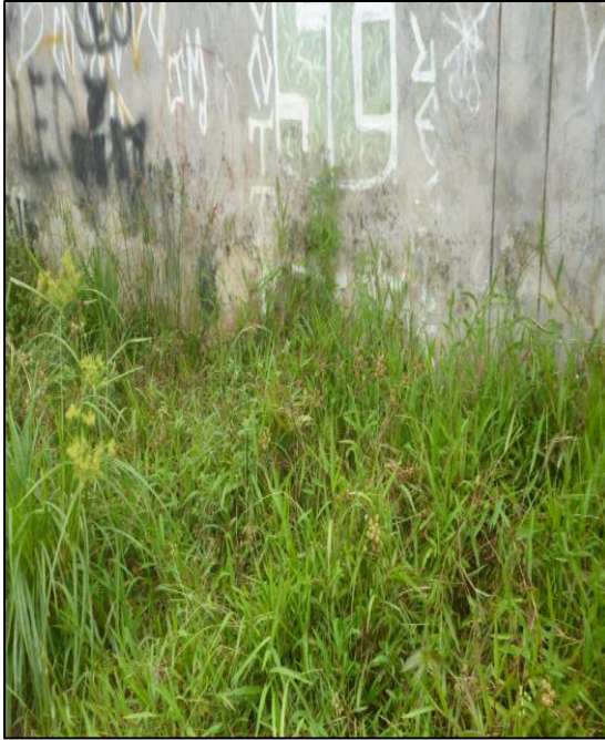
Fotografía 05: Organismo Identificado en Muro confinado, se encuentran en la UM-03 y UM 10, y ambas tienen un nivel de severidad Leve.
