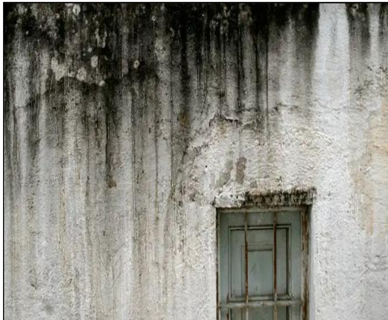
Figura 26. Moho en vigas de confinamiento Nota. Fuente: (Consumer E. 2015) 24
