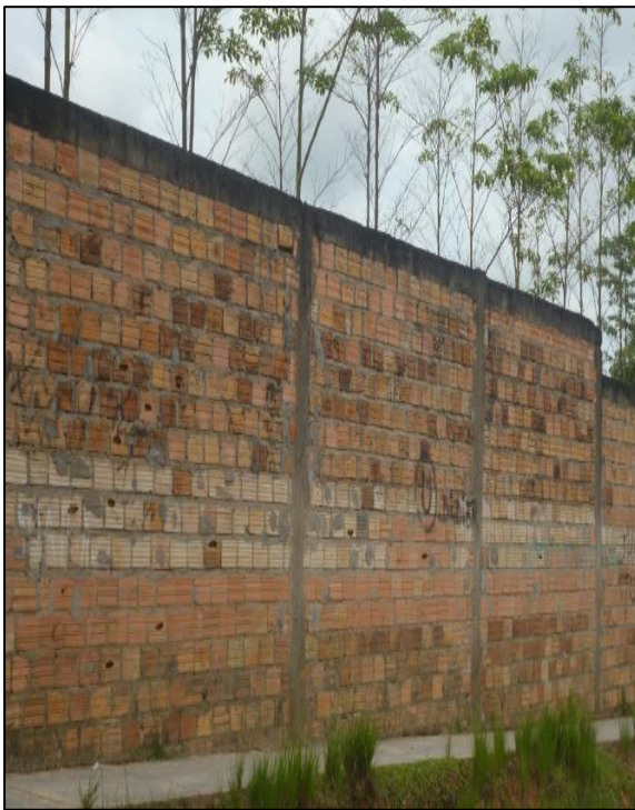
Fotografía 06: Moho Identificado en las vigas de confinamiento, están ubicadas en la UM-02 y UM-11, ambas tienen un nivel de severidad Moderado.
