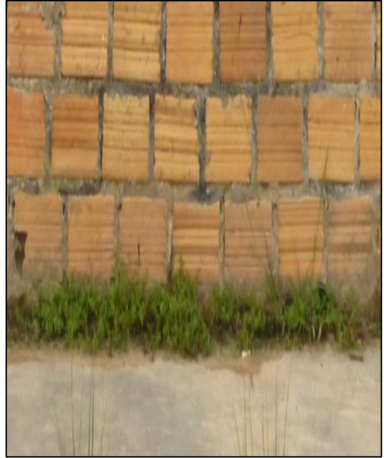
Fotografía 05: Organismo Identificado en Muro confinado, se encuentran en la UM-03 y UM 10, y ambas tienen un nivel de severidad Leve.
