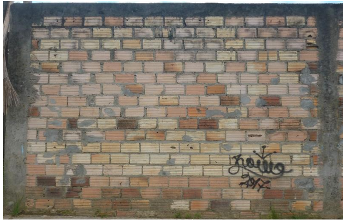
Figura 5. albañilería Confinada Nota. Fuente: (Elaboración propia)
