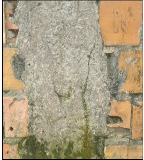
Fotografía 04: Patología Grieta identificados en la columna ubicada en la UM-13 con un nivel de severidad Moderado.
