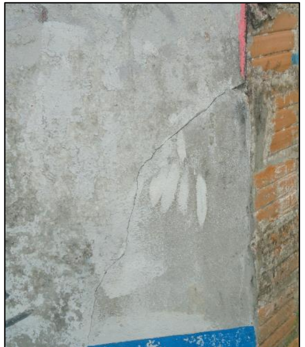
Fotografía 05: Patología Fisura identificado en muro de albañilería, ubicada en la UM-05 con un nivel de severidad Moderado.
