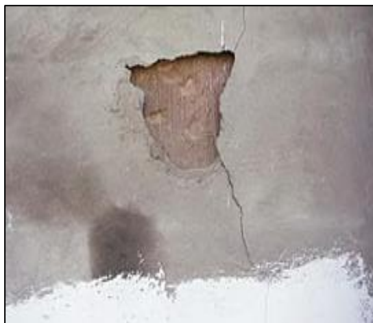
Figura 19. Desprendimiento Nota. Fuente: (Enciclopedia Broto. 2012) 26
