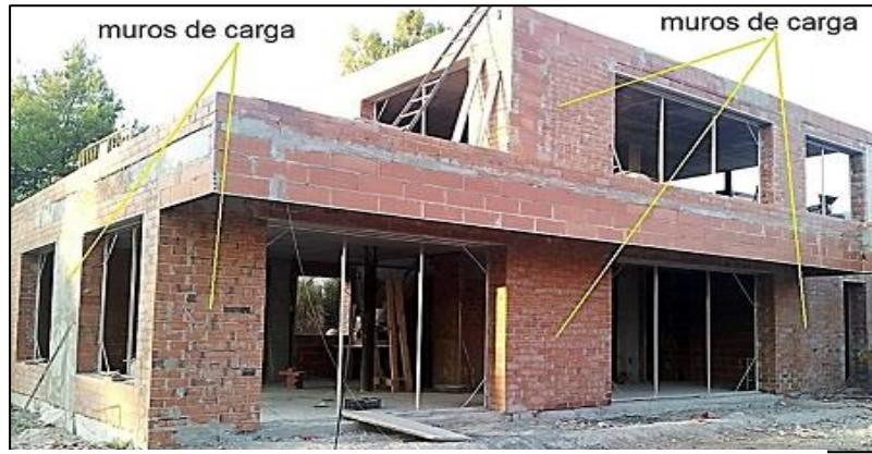
Figura 5. Muro de Carga Nota. Fuente: (Medina C. 2015) 14
