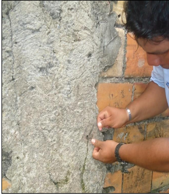
Fotografía 04: Patología Grieta identificados en la columna ubicada en la UM-13 con un nivel de severidad Moderado.
