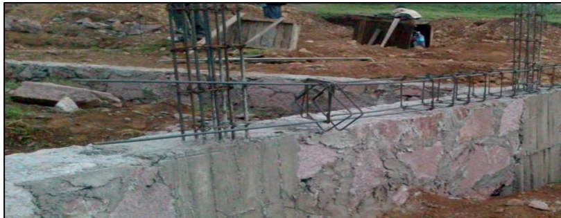
Figura 8. Sobrecimiento Nota. Fuente: (Avalos A.2015) 17
