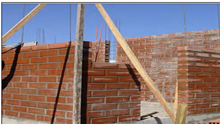
Figura 3. “Albañilería Armada” Nota. Fuente: (Ecu Red.2015) 9
