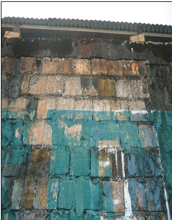
Fotografía 03: Patología Moho Identificado en la viga y muro de albañilería, ubicada en la UM-07 con un nivel de severidad Moderada.
