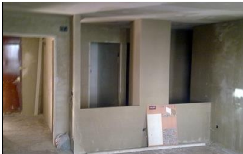
Figura 12. Empastado con mortero Nota. Fuente: (Pérez L.2014) 18
