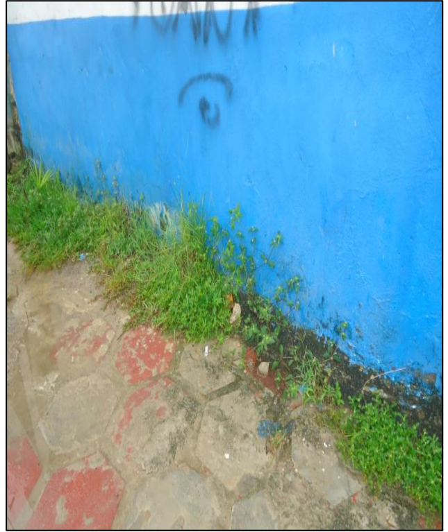
Fotografía 02: Patología Organismos Identificado en el Muro confinado, se encuentra en la UM-11 con un nivel de severidad Moderado.
