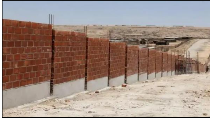
Figura 15. Cerco Perimétrico Nota. Fuente: (Ramírez M. 2011) 8
