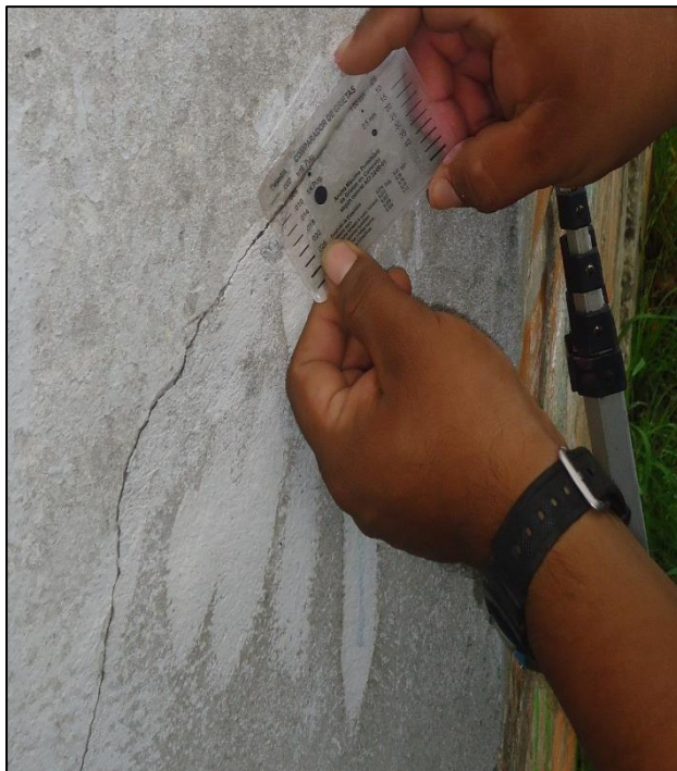
Fotografía 05: Patología Fisura identificado en muro de albañilería, ubicada en la UM-05 con un nivel de severidad Moderado.
