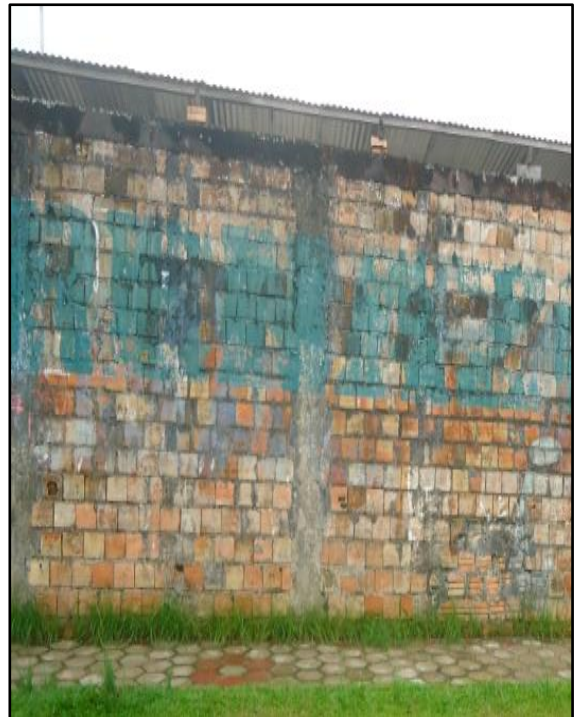
Fotografía 03: Patología Moho Identificado en la viga y muro de albañilería, ubicada en la UM-07 con un nivel de severidad Moderada.
