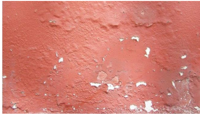
Figura 11: Descascaramiento.
