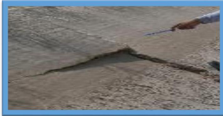
*Figura N° 19: Hundimiento de la losa de concreto.*
