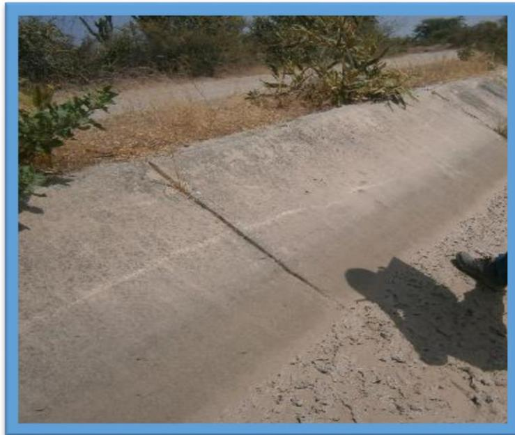
*Figura N° 23: Eflorescencia en el concreto.*
