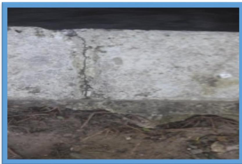
*Figura N° 17: Fisura en concreto.*
