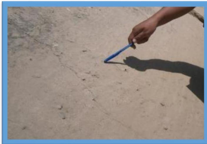
*Figura N° 22: Descascar amiento de concreto.*
