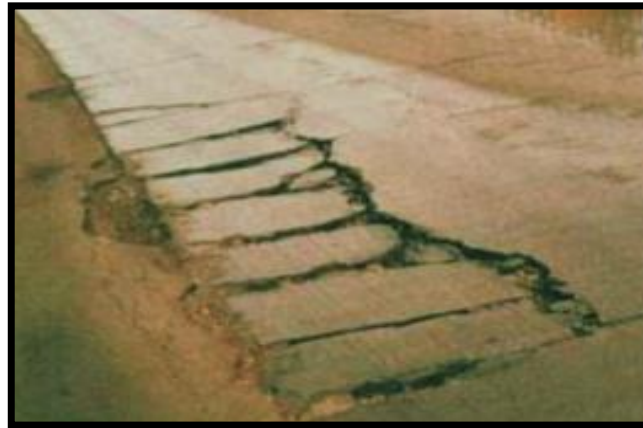
Figura 10. Gráfico de falla estructural de pavimento rígido
