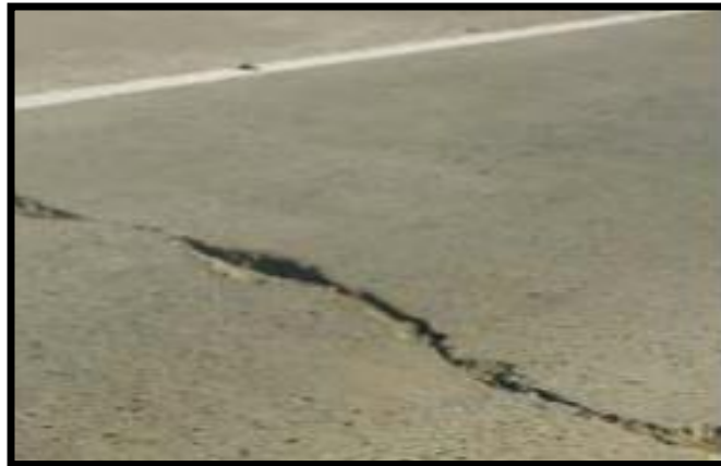
Figura 11. Gráfico de falla superficial de pavimento rígido
