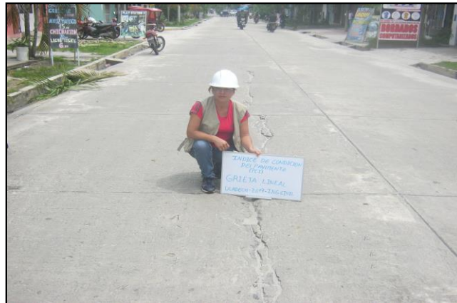
Figura 26: Grieta Lineales
