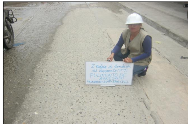
Figura 29: Pulimiento de Agregado
