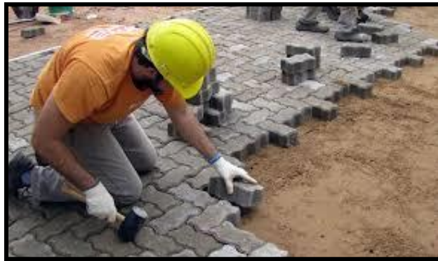
Figura 08. Técnicas de Colocación de un Pavimento Articulado
