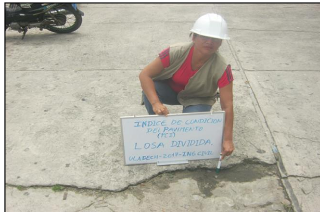
Figura 25: Losa Dividida
