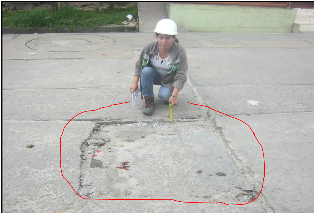
Figura 111: Foto parcheo pequeño de severidad alta.
