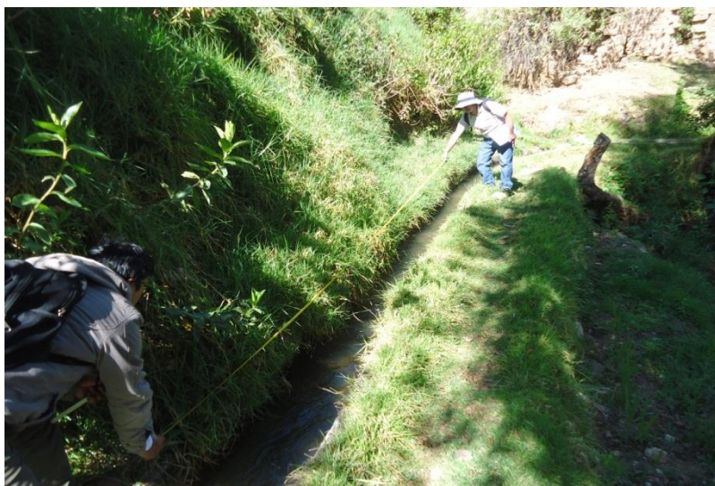
Fotografía 06: Tomando datos de la patología vegetación en el canal.
