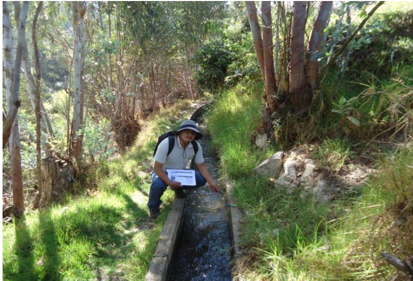
Fotografía 02: Identificando patologías del concreto en el canal.
