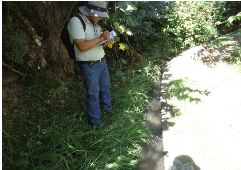
Fotografía 05: Tomando datos de la patología vegetación en el canal.
