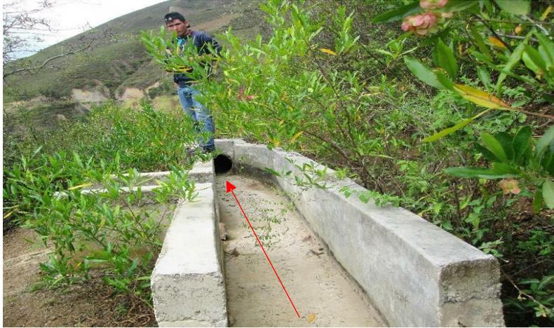
**Figura 13 : Sección transversal tipo circular ejemplo uso de tubería.**
