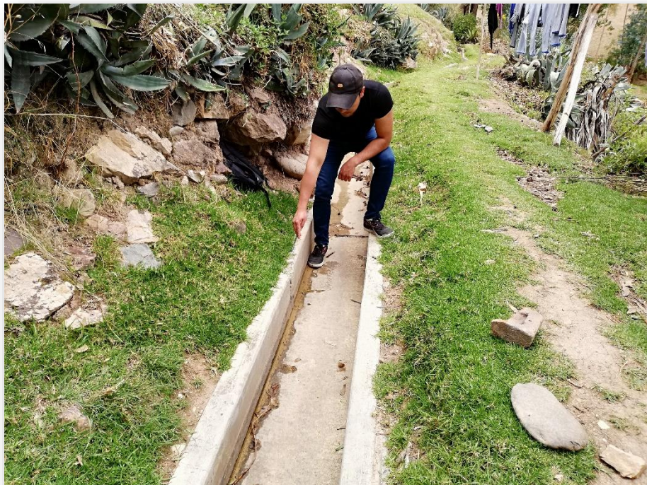
Se aprecia la patología crecimiento de vegetación en juntas
