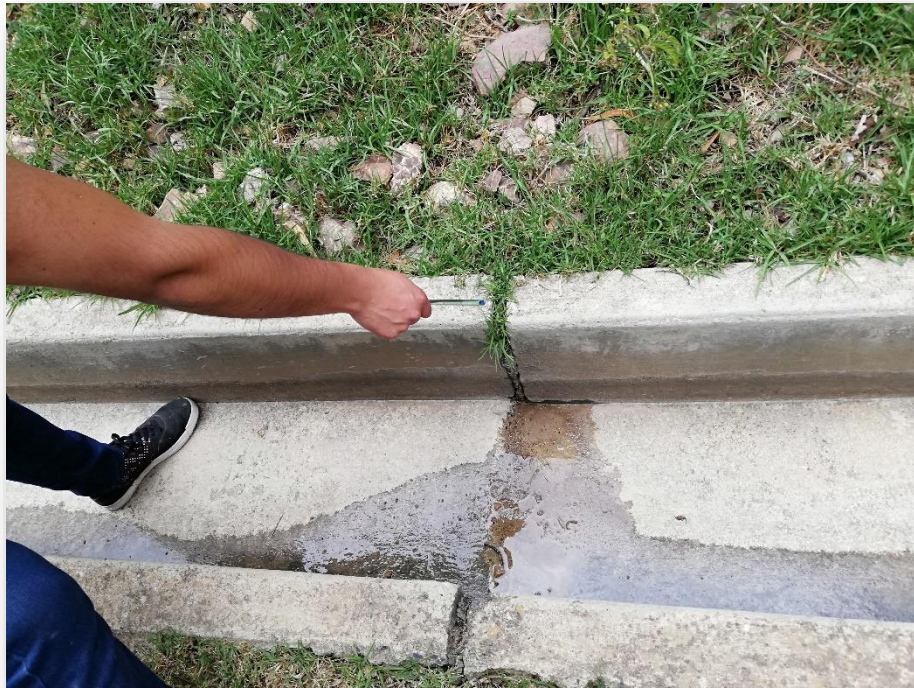
Se aprecia la patología crecimiento de vegetación en juntas
