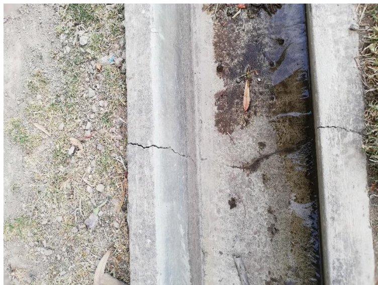
Figura 11: Grietas transversales.
