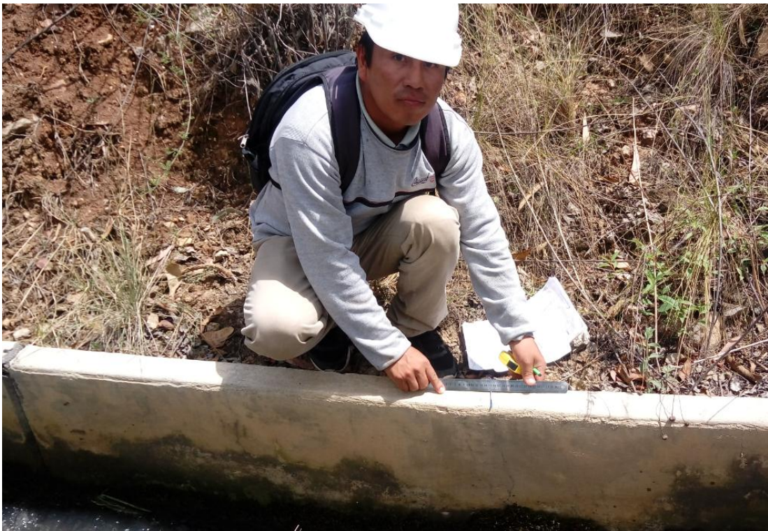
Foto N° 04: Midiendo las Patologías
