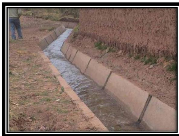
*Figura 14. Juntas Transversales de Contracción.*
