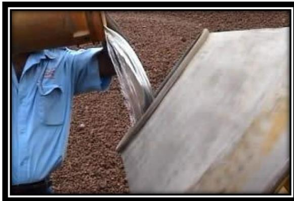
*Figura 11.* Agua para el concreto.
