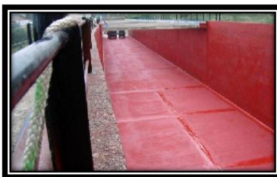
*Figura 15.* Juntas Longitudinales de Contracción.
