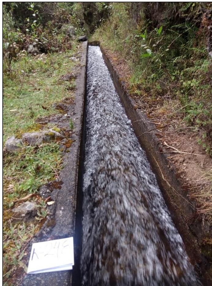
**Fotografía 2:** Sección trapezoidal y rectangular del canal Pokiac Norte.
