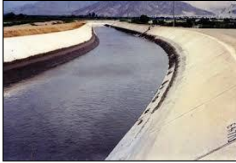
Figura 2: Canal de primer orden.
