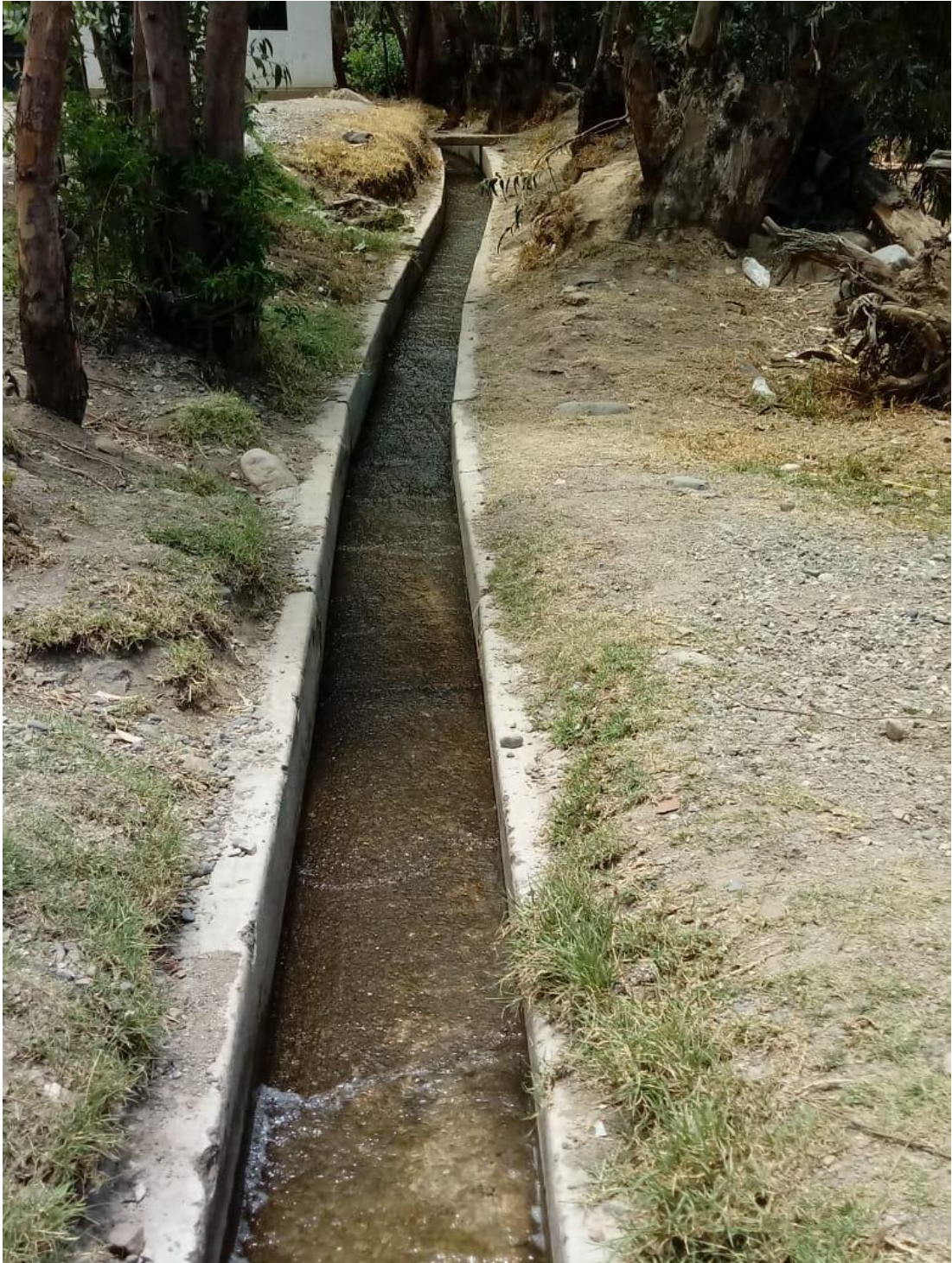
Fotografía N°01: Vista del canal de riego Chullcu
