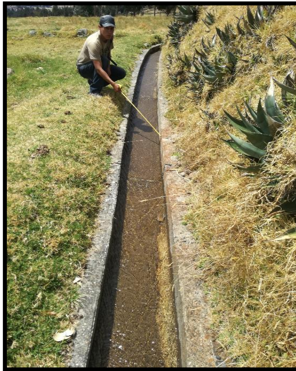
Vista del canal de riego de Cayac, donde se puede ver la pendiente que tiene en ciertos tramos y de esta manera se da un mayor grado de erosión.
