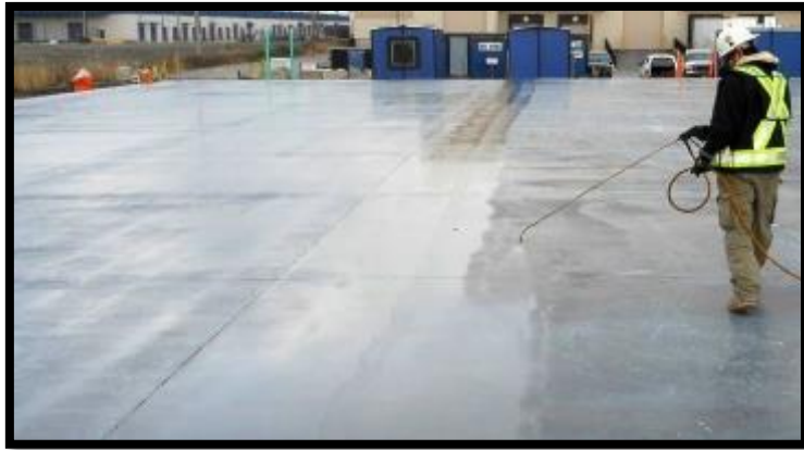
Figura 11: agua para concreto.
