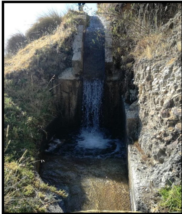
Vista del final del canal, el cual aún cumple con su función.
