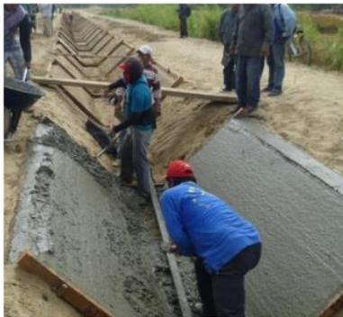
**Imagen 05:** Canal de riego de sección triangular
