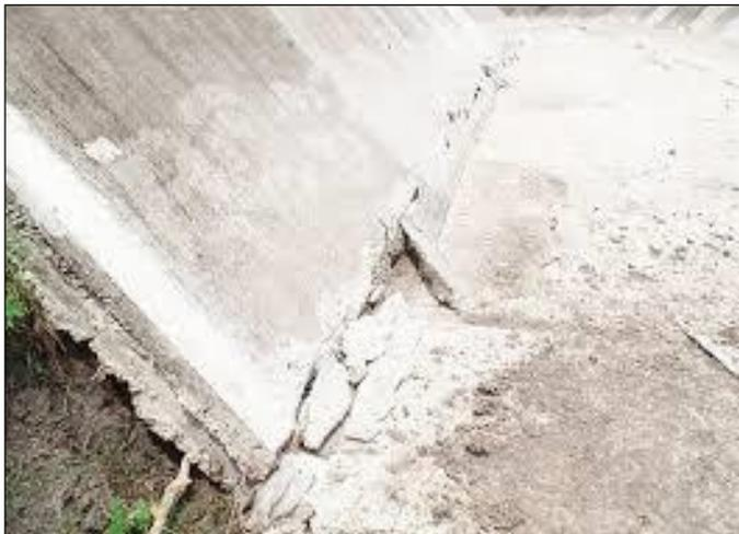
**Imagen 11:** Agrietamiento en un canal trapezoidal.
