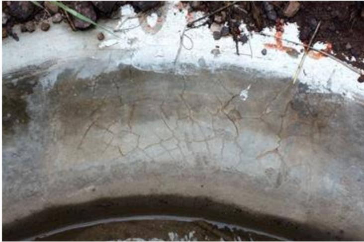
**Imagen 10:** Fisuras superficiales en la parte lateral de un canal de regadío.
