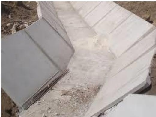
**Imagen 03:** Canal de riego de sección trapezoidal
