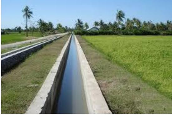
**Imagen 04:** Canal de riego de sección rectangular
