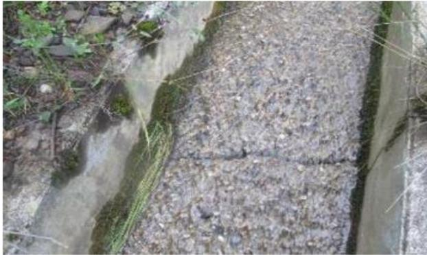
**Imagen 09:** Fenómeno de erosión en la base de un canal de concreto.
