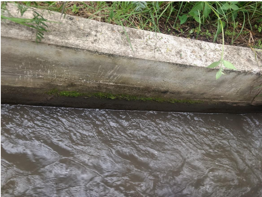
Imagen N° 6 Canal de riego Puchca. Se observa la presencia de musgo
