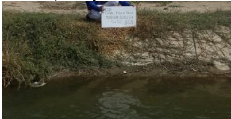
Gráfico 8: Vegetación en canal de concreto.
