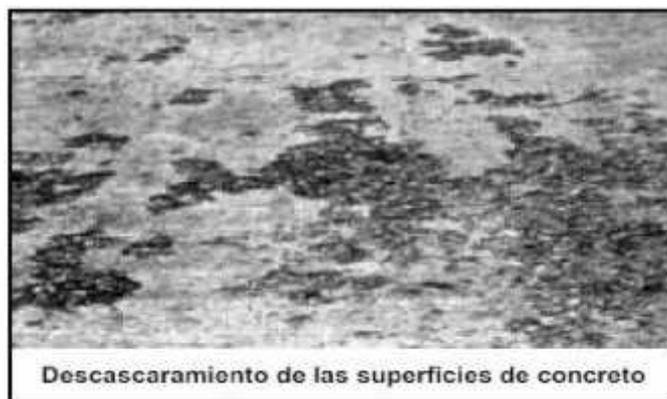
**Gráfico N° 08: Descascaramiento de las superficies de concreto.**
