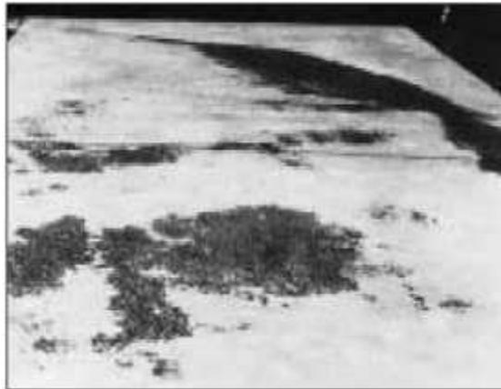
**Gráfico N° 04: Decoloración en la superficie de concreto.**
