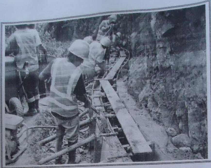
VISTA: VACIADO DE CONCRETO DE MUROS LATERALES DEL CANAL HUANCHACPAMPA, UTILIZANDO LA VIBRADORA.
