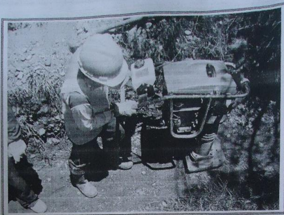
VISTA: COMPACTADO DE ZANJAS DEL CANAL CON UNA PLANCHA TIPO CANGURO.
