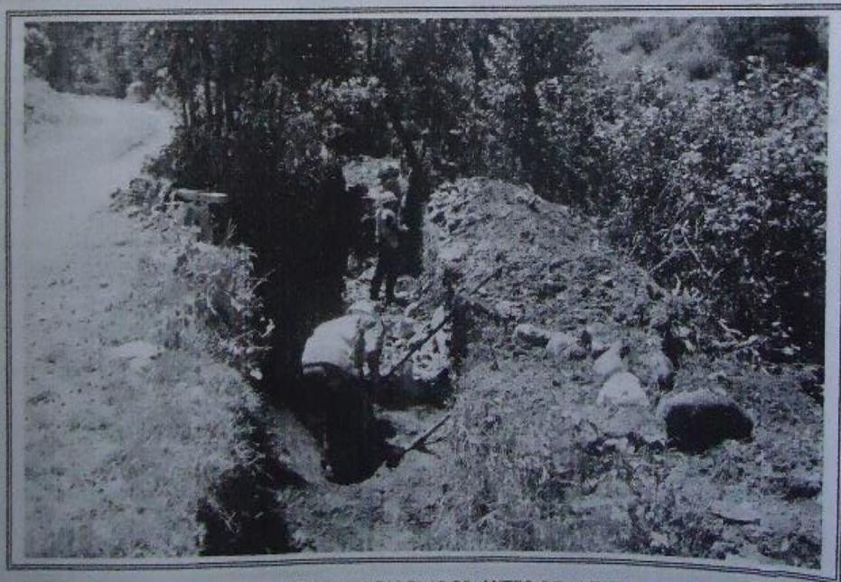
VISTA: EXCAVACION DE ZANJAS DEL DESARENADOR ANTES DE LLEGAR A LA CARRETERA Y CERCA AL RIO NEGRO.
