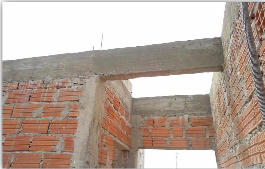
**Figura 06:** Viga de concreto armado - Fuente: Escalante T.
