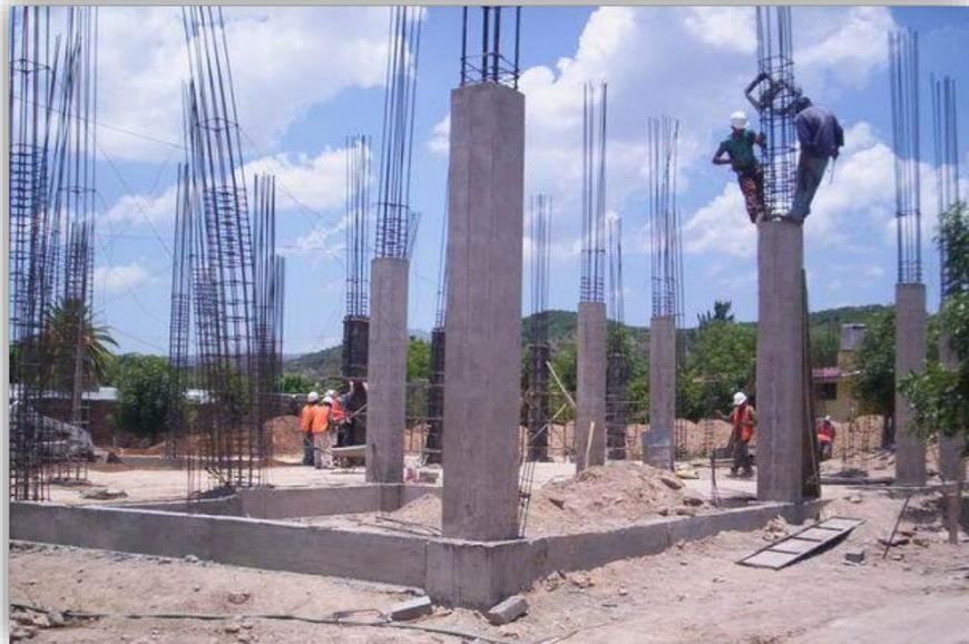
**Figura 07:** Columna de concreto armado - Fuente: Página de Arquys.com
