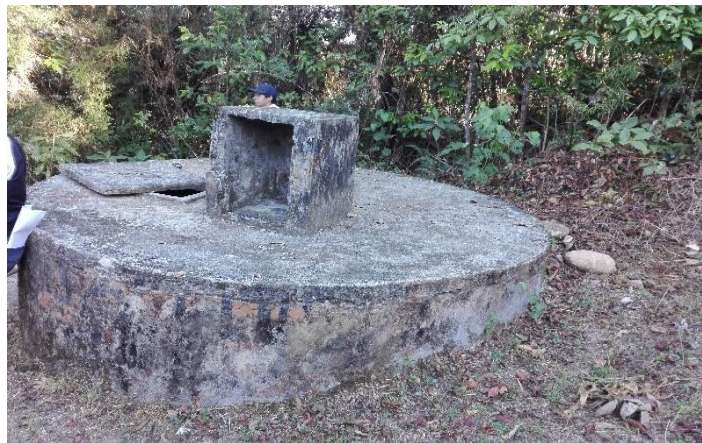
Gráfico N° 02: Reservorio Enterrados o Subterráneos
