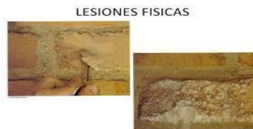
Gráfico N° 06: Presencia de Criptoflorescencia
