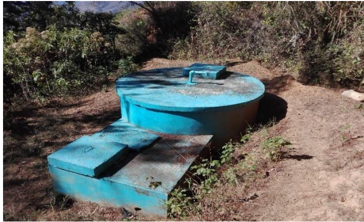
Gráfico N° 03: Reservorio Apoyado
