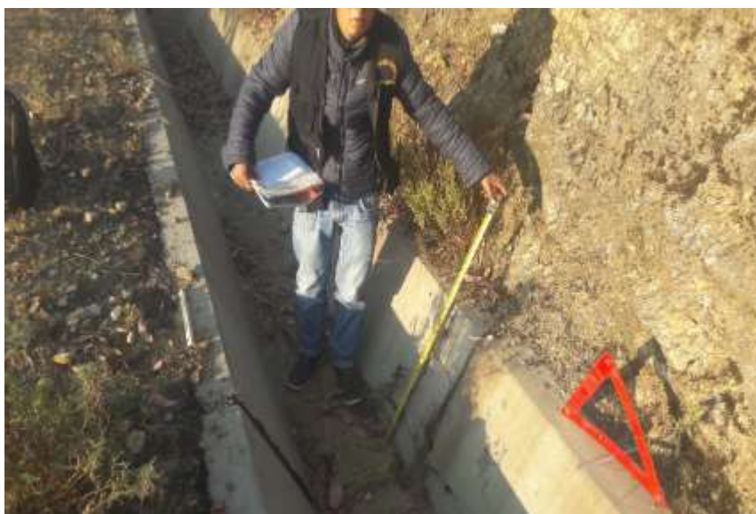
FOTO N° 04: Fotografía del Canal de irrigación Huecrococha mi persona tomando medidas.
