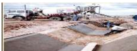
Imagen 08: Vaciado de concreto en canal
