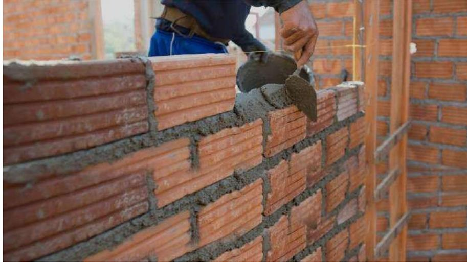
Figura 13. Albañil levantando un muro de albañilería de sogá con ladrillos de arcilla.
