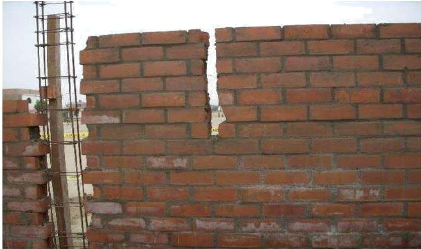
Figura 17. Vista de columna antes del encofrar para vaciado de concreto.
