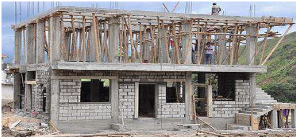
Figura 8. Construcción de muros de albañilería con elementos de Confinamiento.
