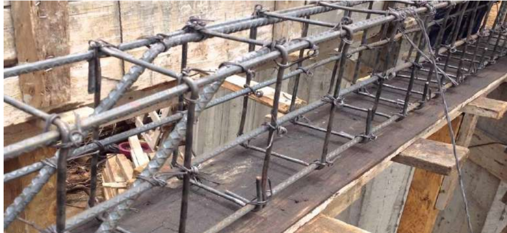
Figura 15. Acero en estructura de viga (fierro corrugado). Nota. Fuente: Elaboración propia. (2018).
