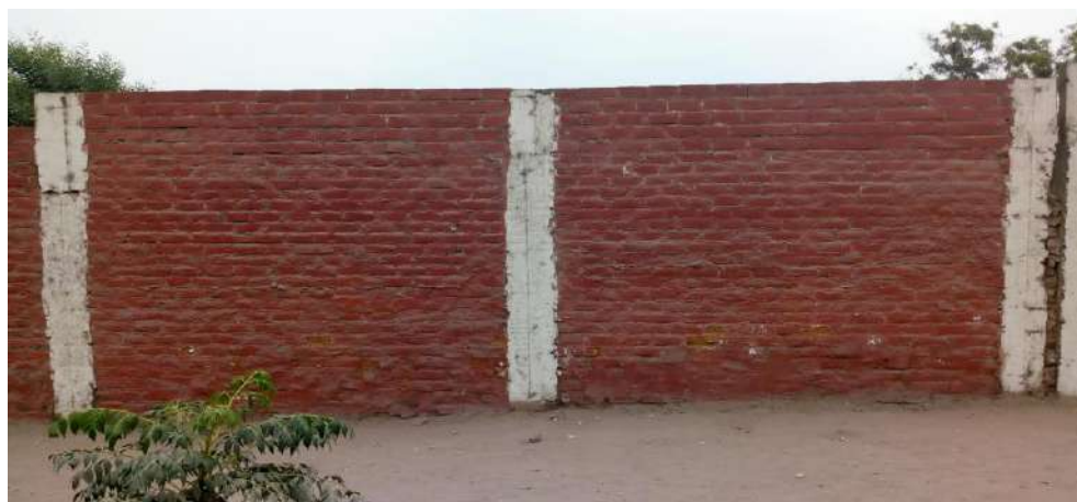
Figura 23. Muro no portante de albañilería. Nota. Fuente: Elaboración propia. (2018).
