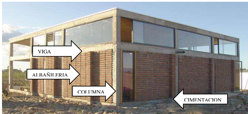
Figura 7. Ilustración de los componentes de la albañilería confinada. Nota. Fuente: Elaboración propia. (2018).
