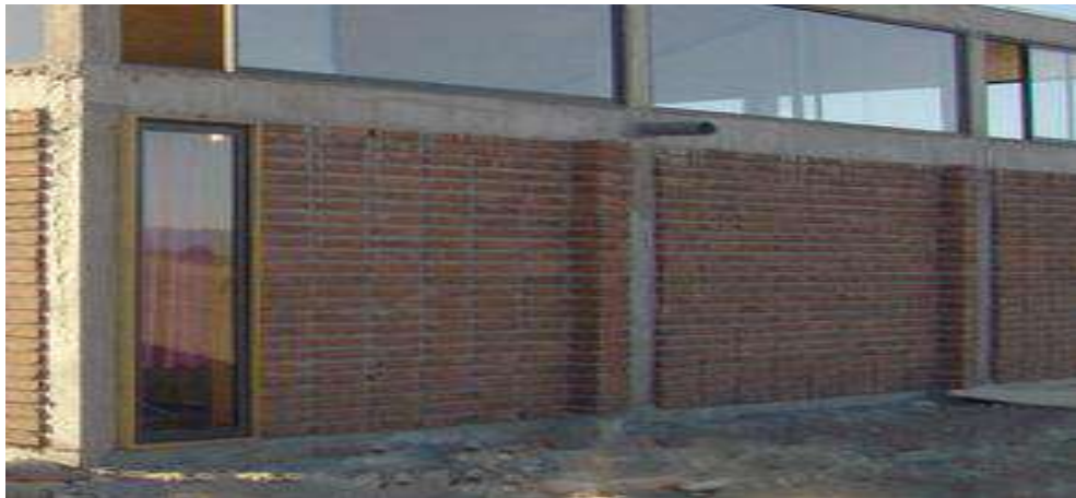
Figura 22. Muro portante de albañilería confinada soportando carga de loza Aligerada.
