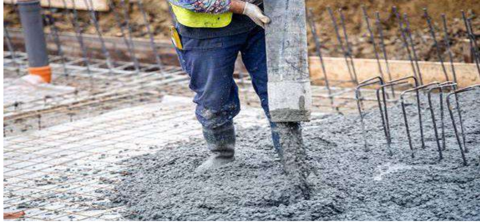
Figura 21. Vaciado de concreto premezclado utilizando una bomba estacionaria.
