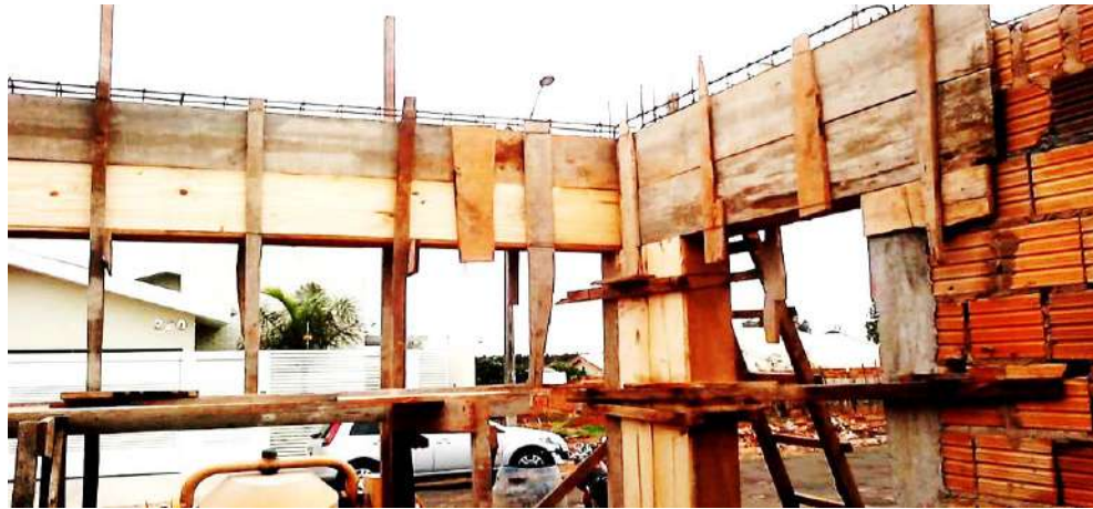
Figura 9. Armadura y encofrado de viga de concreto armado. Nota. Fuente: Elaboración propia. (2018).
