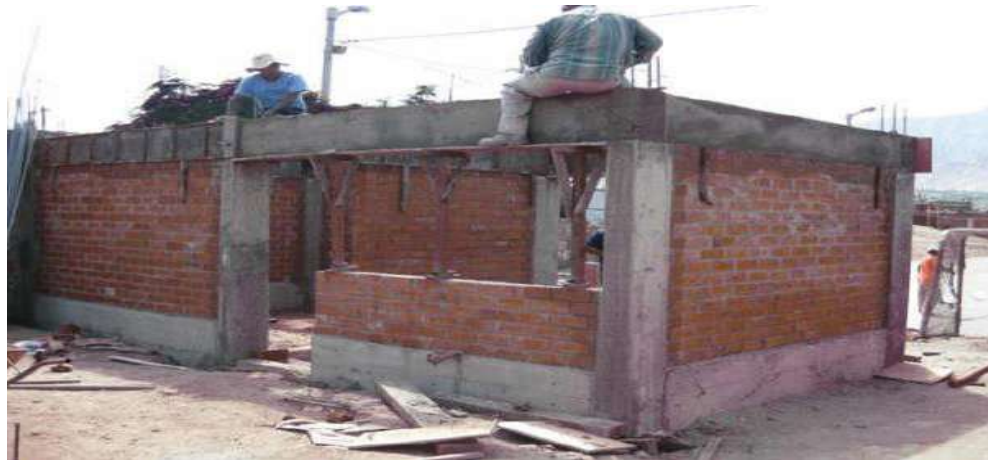
Figura 6. Edificación construida mediante sistema confinado. Nota. Fuente: Elaboración propia. (2018).
