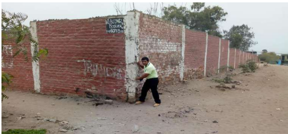
Figura 32. Vista panorámica del cerco perimétrico de la institución educativa 6073 Jorge Basadre.
