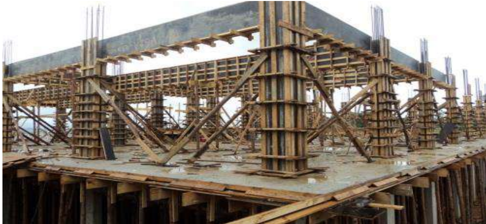
Figura 10. Encofrado de columna de concreto armado. Nota. Fuente: Elaboración propia. (2018).
