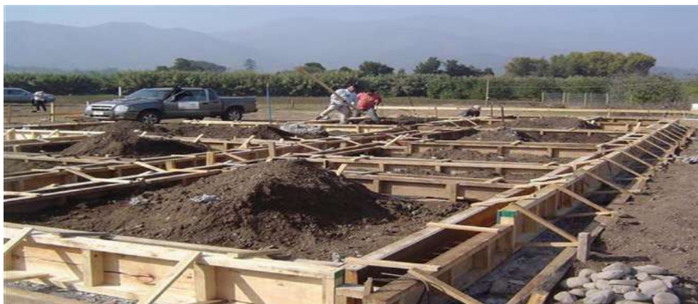
Figura 12. Encofrado de sobrecimiento. Nota. Fuente: Elaboración propia. (2018).
