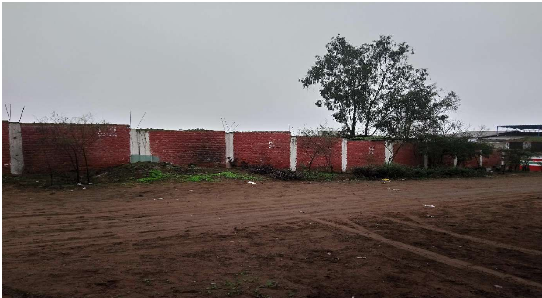
Fotografía 2: Vista panorámica margen derecho del cerco perimétrico de la Institución Educativa 6073. Jorge Basadre Nivel Secundaria, avenida Ricardo Palma N° 600 – Distrito de Villa María del Triunfo – Lima.
