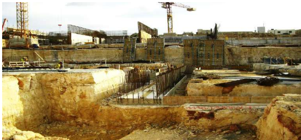
Figura 11. Cimentación de concreto armado. Nota. Fuente: Elaboración propia. (2018).
