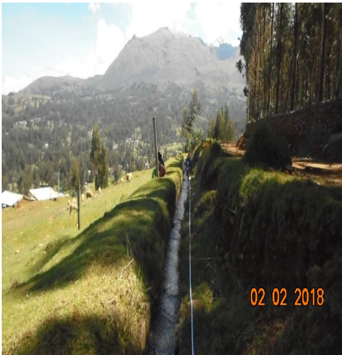
Fotografía 01: Vista del canal del sector Huacrajirca Huanchac.
