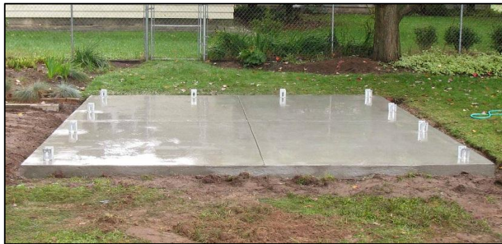
Figura 12. Losa de concreto simple.
