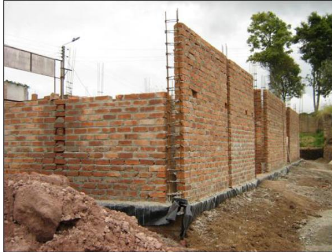
Figura 9. Asentado de unidades de albañilería en muro. Nota. Fuente: Gonzales, L. (2015).
