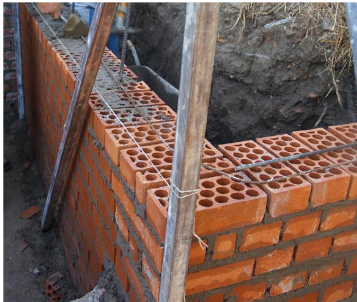
Figura 4. Construcción de muros de albañilería simple. Nota. Fuente: Monroy, M. (2012).
