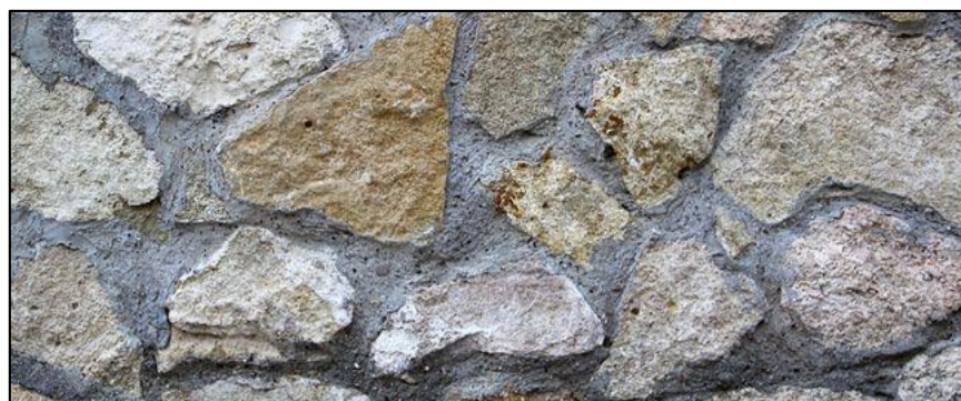
Figura 14. Concreto ciclópeo. Nota. Fuente: Gisbert, E. (2014).
