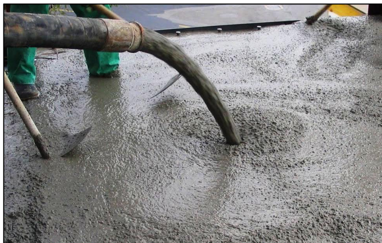
Figura 11. Vaciado de concreto premezclado en losa. Nota. Fuente: Concreto Vale. (2016).
