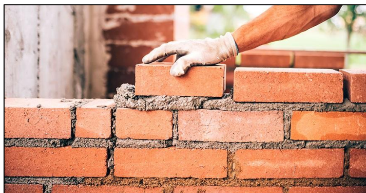
Figura 17. Asentado de unidades de albañilería con mortero.
