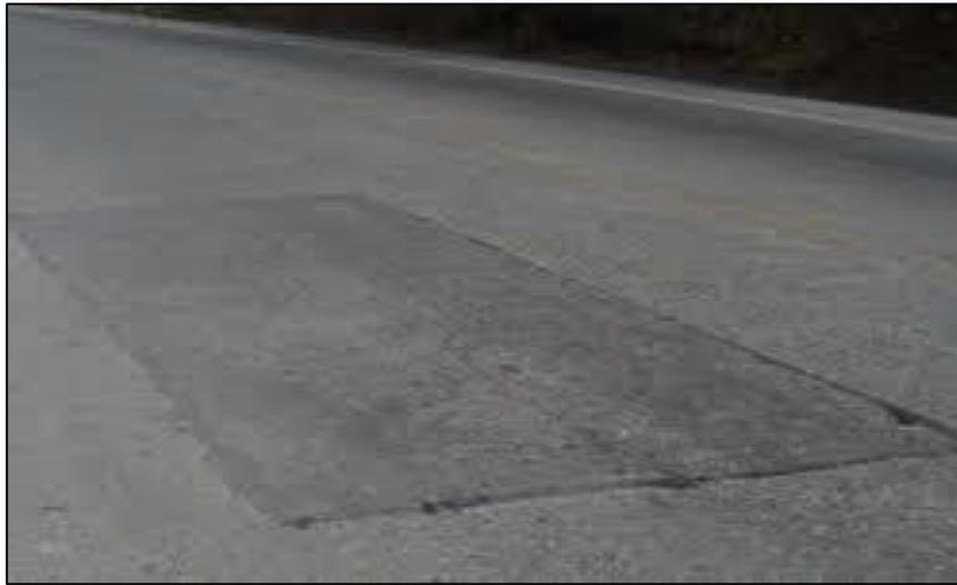
Figura 13; Falla de un parche grande en pavimento rígido
