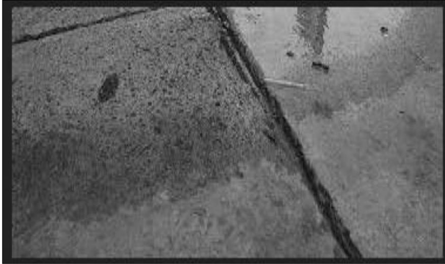
Figura 10; Falla de escala en pavimento rígido
