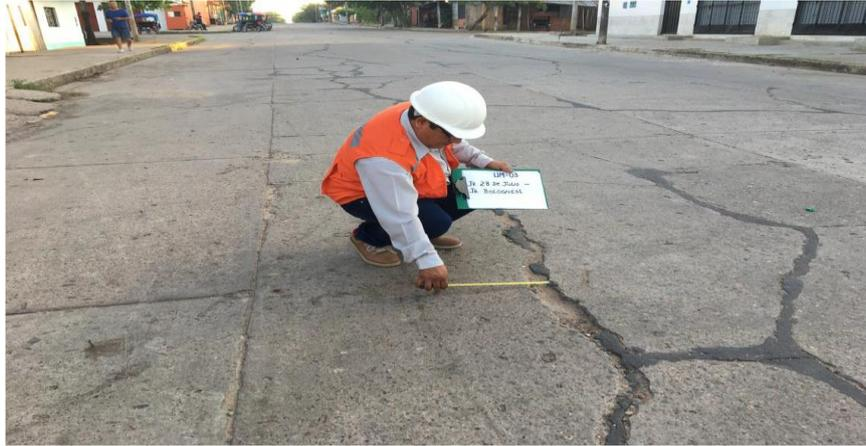
Figura 2; Pavimento rígido deteriorada en el distrito de Capaz
