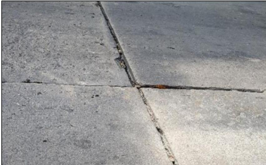
Figura 12; Falla desnivel de carril / berma en pavimento rígido
