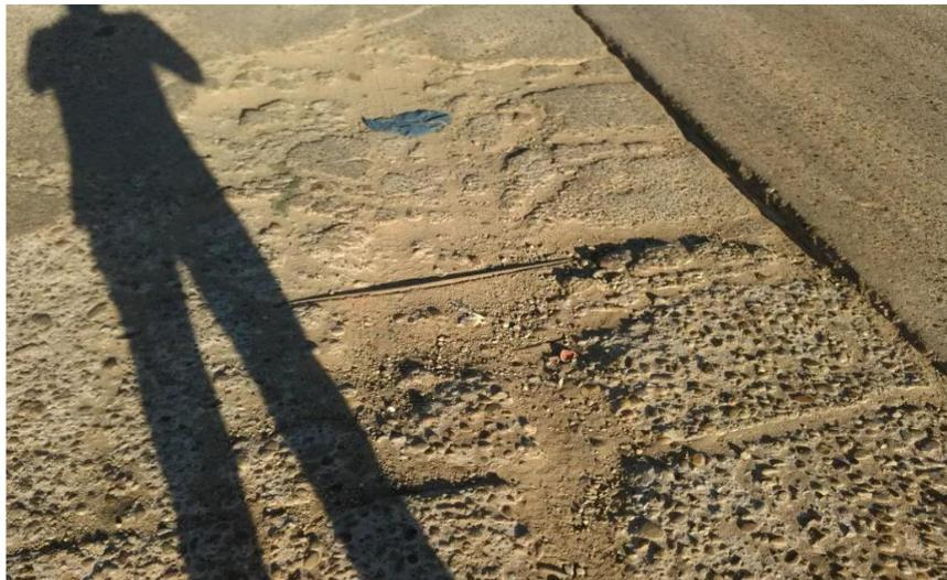
Figura 3; Pavimento rígido deteriorada en la provincia Huamanga
