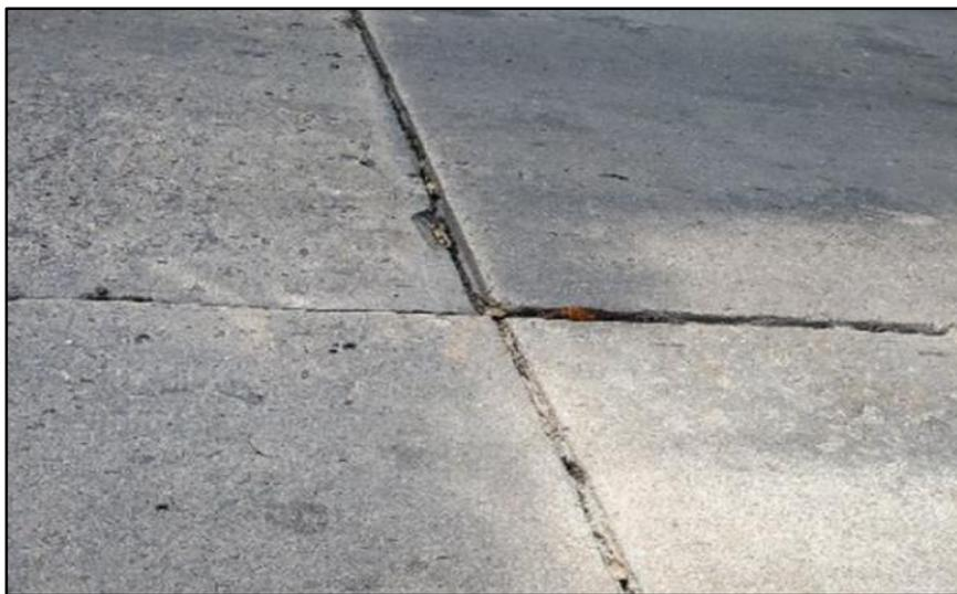
Figura 11; Falla daño de junta en pavimento rígido
