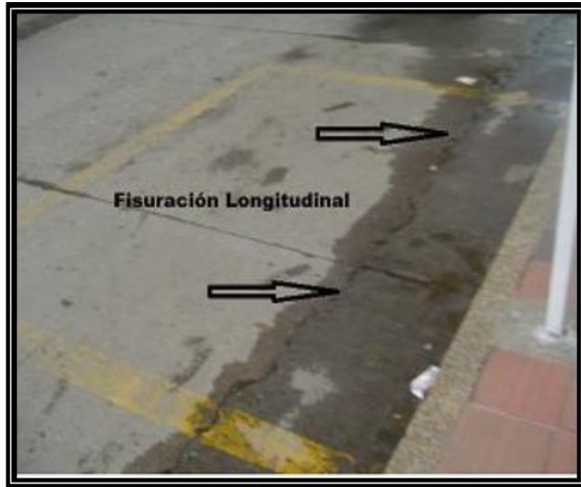
Figura 01. Fisuración Longitudinal.
