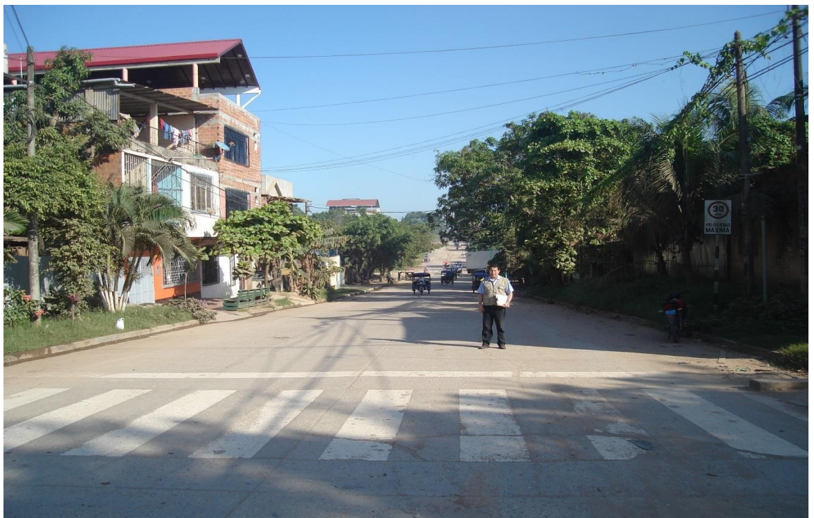
Figura N° 117: Vista de Patologías en la cuadra 05 del Jirón Cahuide
