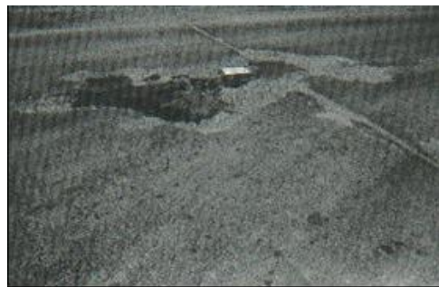
Descaramiento de esquina
