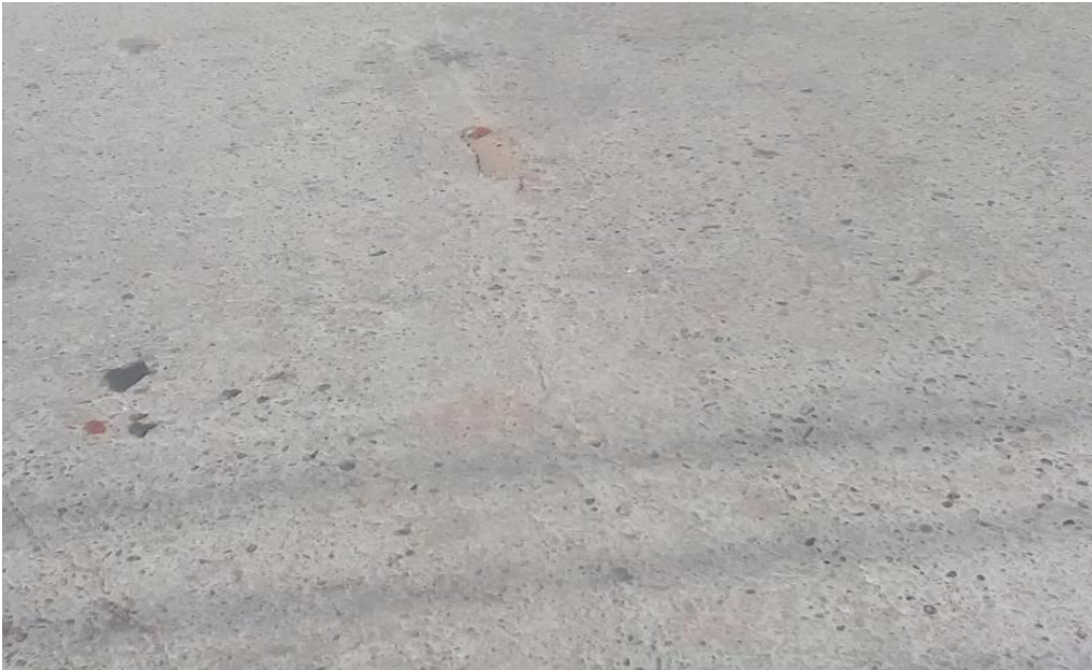
Pulimientos de agregados
