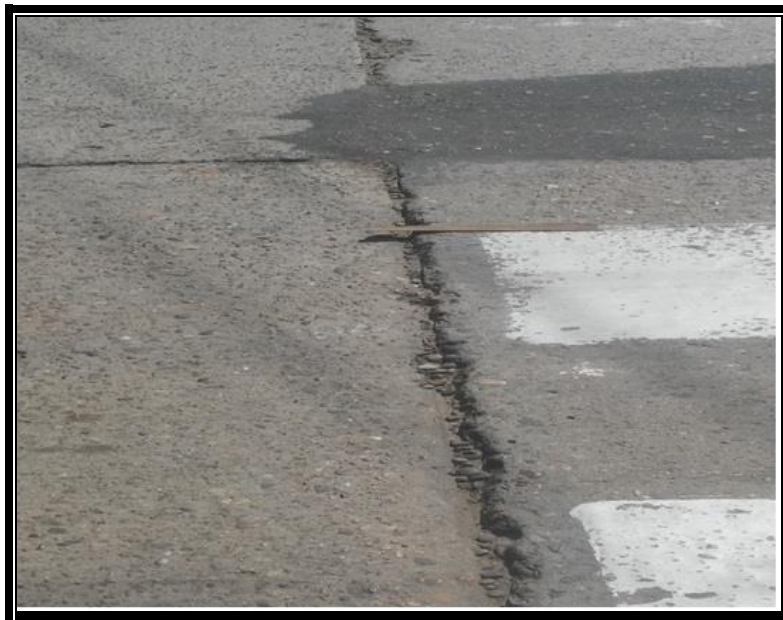
(sellos de juntas ,pulimento de agregado) del jirón Atahualpa (2017)
