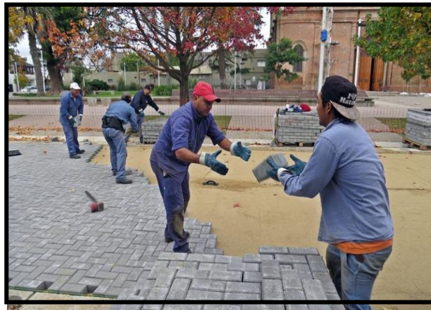
Figura N° 09. Pavimento Articulado.
