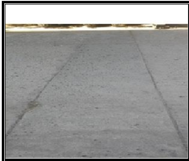
(pulimento de agregado, parches grandes) del jirón Atahualpa (2017)
