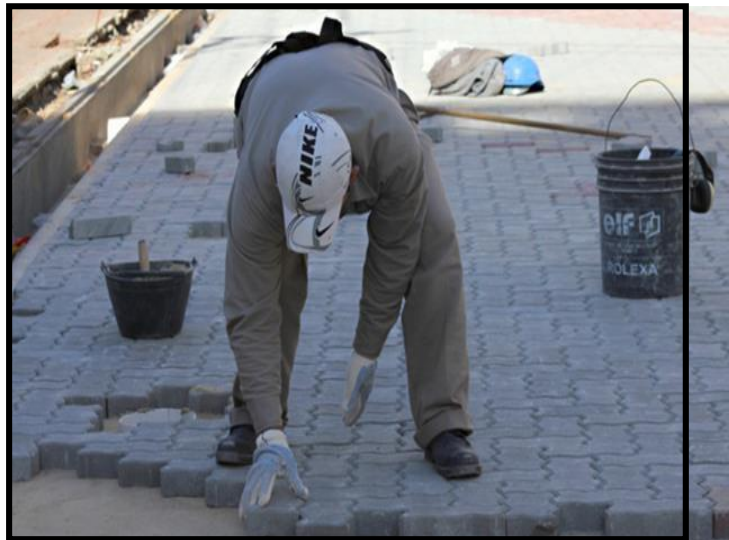
Figura N° 08. Técnicas de Colocación de un Pavimento Articulado
