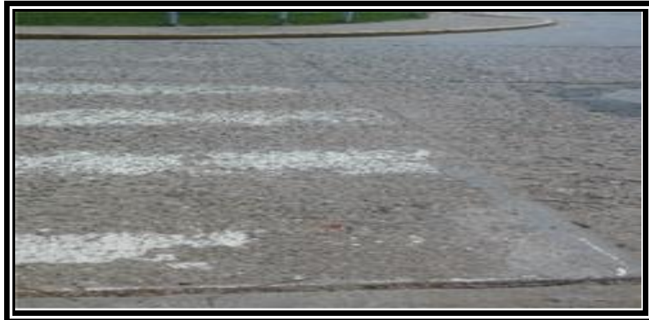
Vista panorámica (pulimento de agregado) del jirón Atahualpa (2017)
