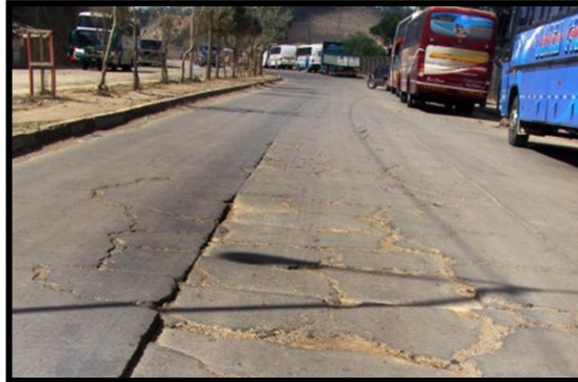
Figura N° 10. Gráfico de falla estructural de pavimento rígido
