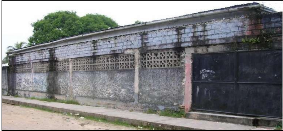
Figura 3. Vista frontal del cerco perimétrico de la institución educativa inicial 170
