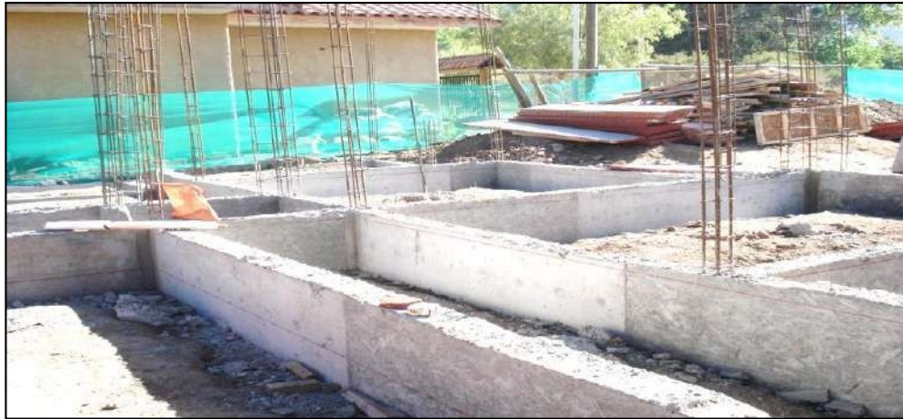
Figura 11. Vista de la estructuración del sobrecimiento. Nota. Elaboración propia. (2018)
