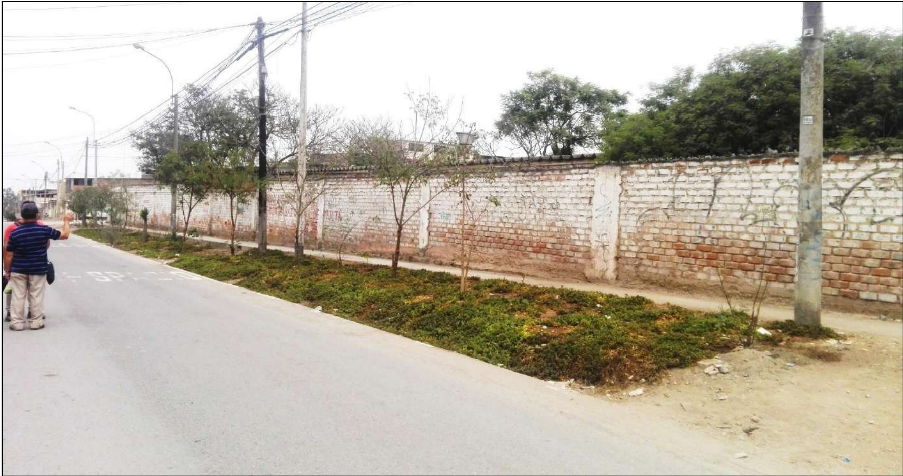
Fotografía 4: Vista panorámica de la Institución Educativa inicial 520. Ubicado en el jirón inca pachacutec con Alfonso Ugarte 850 manzana 8Q, del distrito de villa maría del triunfo, provincia de lima, de la región lima. (Av. Manco Cápac).
