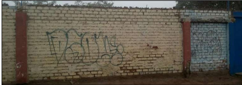
Figura 6. Albañilería confinada del cerco perimétrico de la Institución Educativa Inicial 520.
