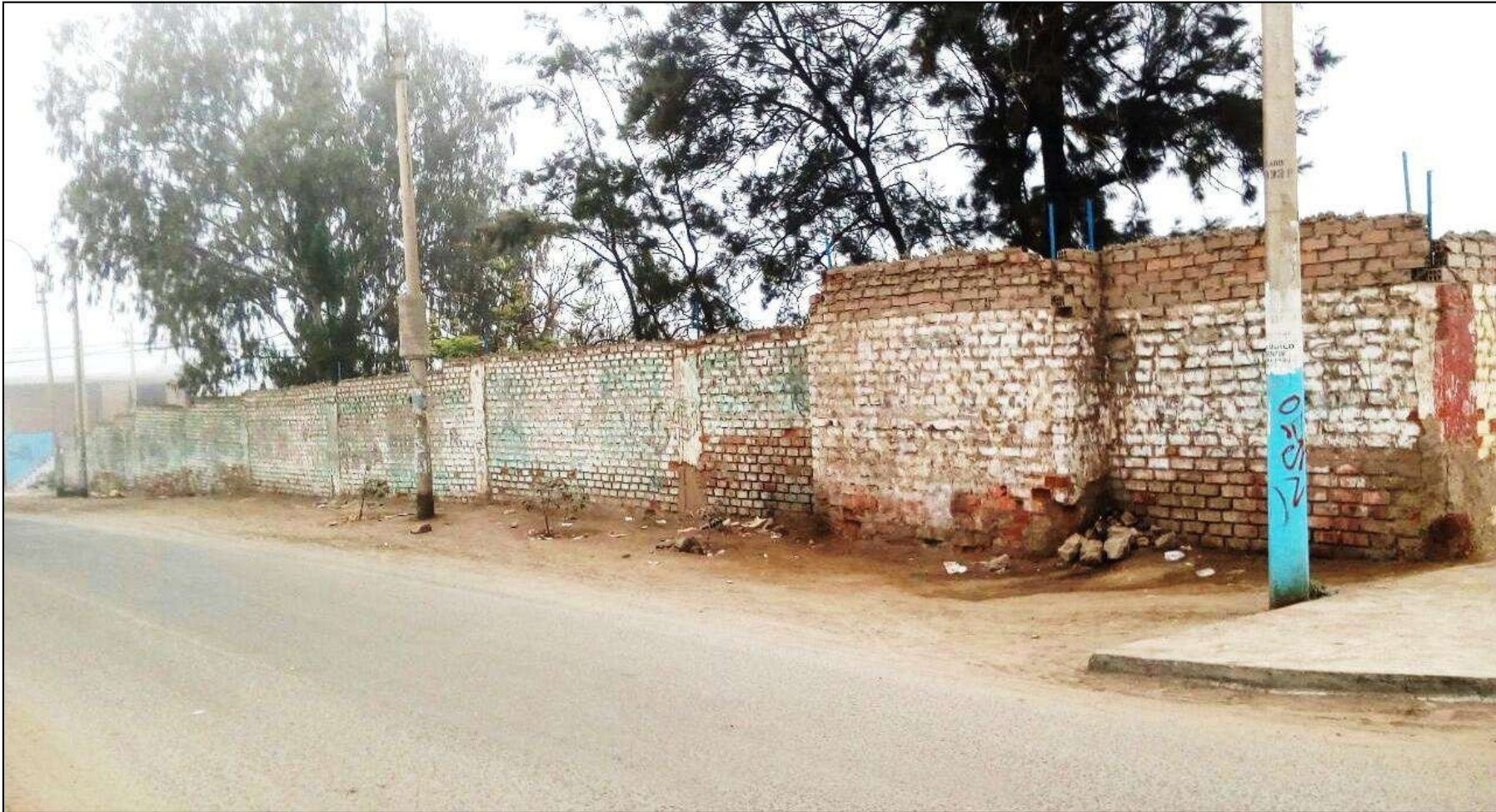
Fotografía 5: Vista panorámica de la Institución Educativa inicial 520. Ubicado en el jirón inca pachacutec con Alfonso Ugarte 850 manzana 8Q, del distrito de villa maría del triunfo, provincia de lima, de la región lima. (Jirón Elías Aguirre).
