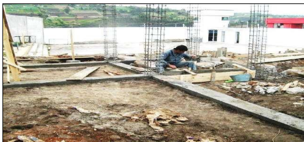
Figura 9. Cimentación de concreto.
