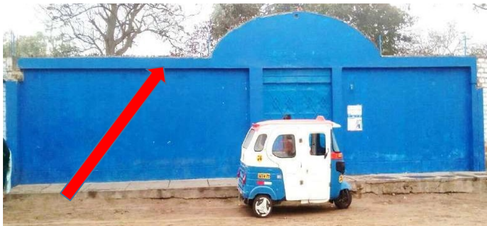
Figura 7. Vigas de concreto armado. Nota. Elaboración propia. (2018)
