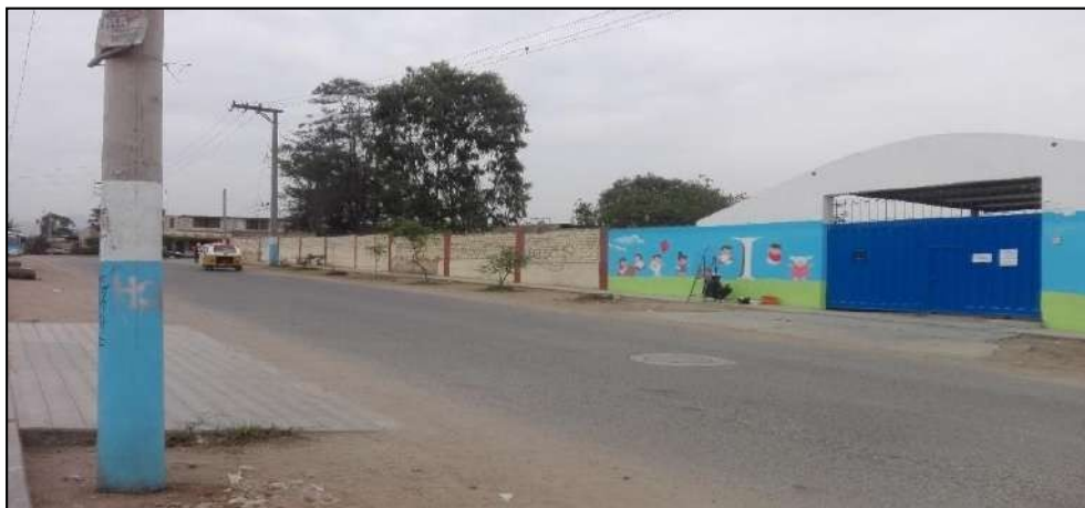
Figura 26. Vista panorámica del cerco perimétrico de albañilería de la Institución educativa inicial 520.
