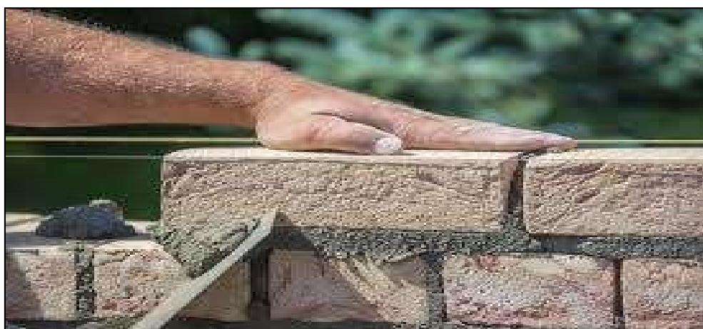
Figura 14. Mezcla de mortero en asentamiento de unidad de albañilería.
