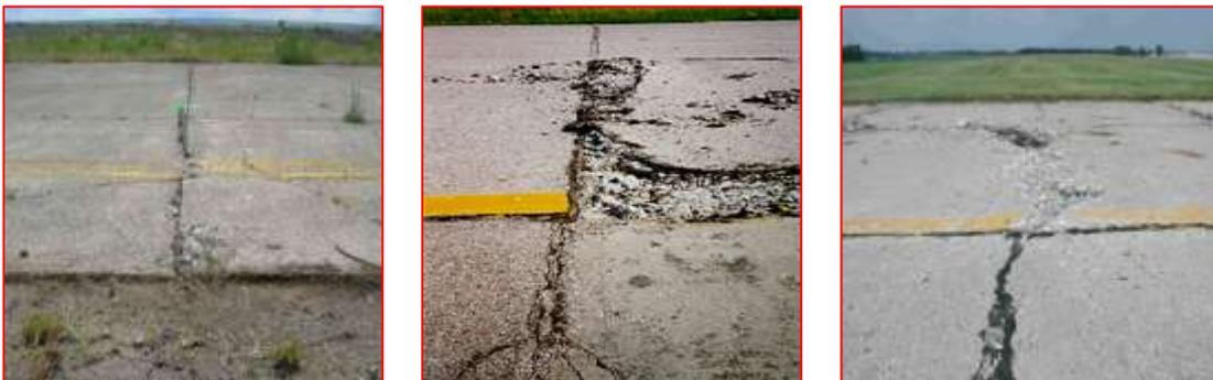
Ilustración II-1: Blowup – buckling de severidad baja, media y alta. Fuente: <https://www.in.gov/indot/div/aviation/pavement-inspection/pci-review/distresses-pcc/pcc-blowup-high.jpg>
