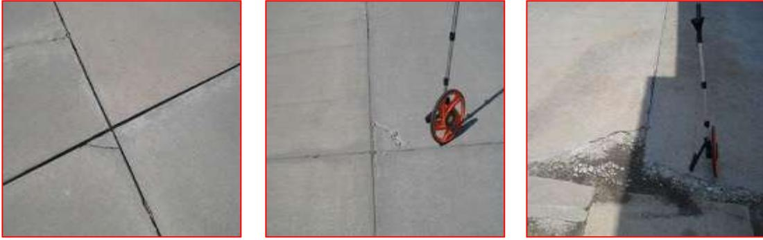
Ilustración II-18: Descascaramiento de esquina de severidad baja, media y alta.
