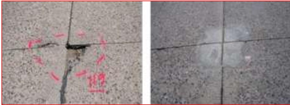
Imagen 34: Ejemplo de reparación parcial Tipo I en intersección de juntas. Fuente: MinnessotaDepartmentoftransportation, 2016.
