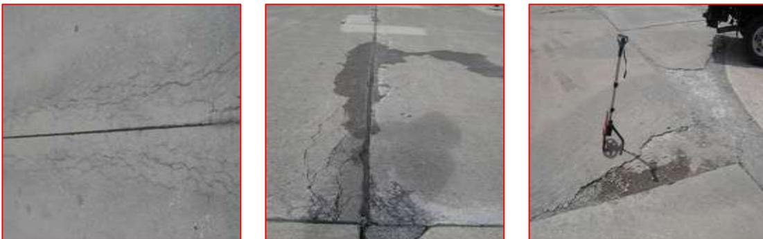
Ilustración II-4: Grieta de Durabilidad D de baja, media y alta severidad. Fuente: <https://faapaveair.faa.gov/Help/Media/image293.jpg>
