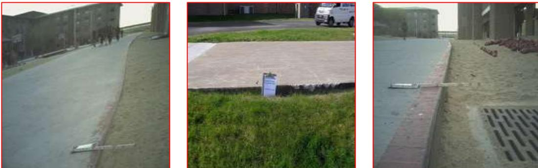
Ilustración II-7: Desnivel carril berma de severidad baja, media y alta. Fuente: <https://faapaveair.faa.gov/Help/Media/image309.jpg>
