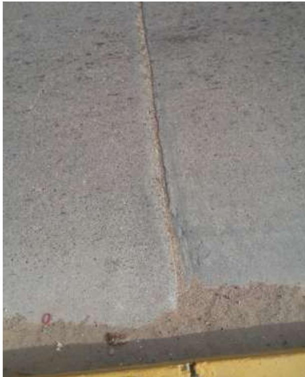
**Imagen 12:** Sello de junta de baja severidad y descascaramiento de junta de baja severidad en la unidad UM 03
