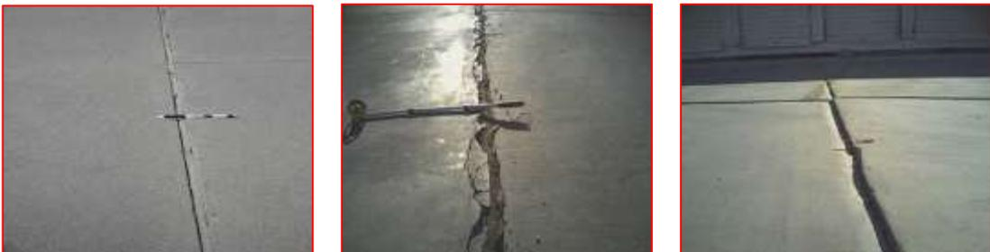
Ilustración II-5: Escala de severidad baja, media y alta. Fuente: <https://faapaveair.faa.gov/Help/Media/image297.jpg>
