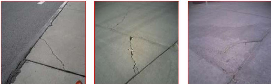
Ilustración II-2: Grieta de esquina de severidad baja media y alta. Fuente: <https://faapaveair.faa.gov/Help/Media/image277.jpg>
