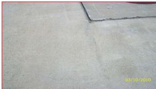
Ilustración II-17: grietas de retracción: Fuente: <https://faapaveair.faa.gov/Help/Media/image349.jpg>
