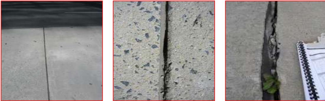
Ilustración II-6: Daño de sello de junta de severidad baja, media y alta. Fuente: <https://faapaveair.faa.gov/Help/Media/image303.jpg>
