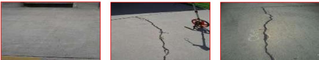
Ilustración II-8: Grieta lineal de severidad baja media y alta. Fuente: <https://faapaveair.faa.gov/Help/Media/image315.jpg>
