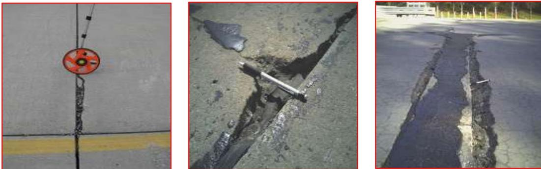
Ilustración II-19: Descascaramiento de junta de severidad baja, media y alta: Fuente: <https://faapaveair.faa.gov/Help/Media/image359.jpg>
