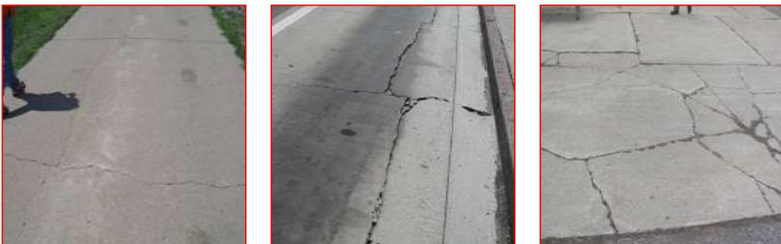
Ilustración II-3: Losa Dividida de severidad baja, media y alta: Fuente: <https://faapaveair.faa.gov/Help/Media/image285.jpg>
