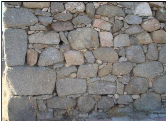
*Figura 15.* Muro de albañilería de piedra
