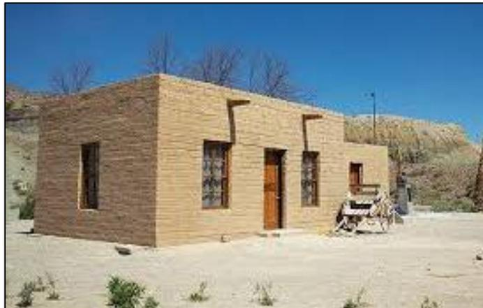
*Figura 16.* Vivienda de albañilería simple.
