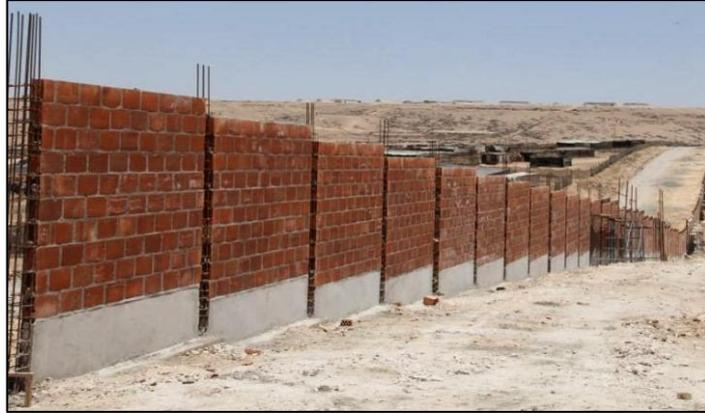
*Figura 14.* Muros de albañilería confinada en cerco perimétrico.
