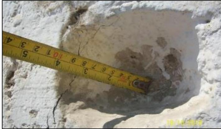
*Figura 27.* Erosión mecánica producto de impactos mecánicos en albañilería.
