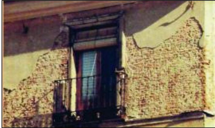
*Figura 26.* Desprendimiento del revoque de la fachada.
