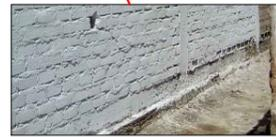
Se observa presencia de la patología **erosión** en muros de albañilería, columnas y sobrecimiento.
