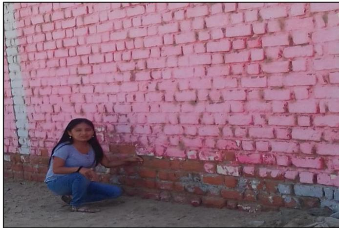
Figura 23. Ilustración de erosión física en muro de albañilería.
