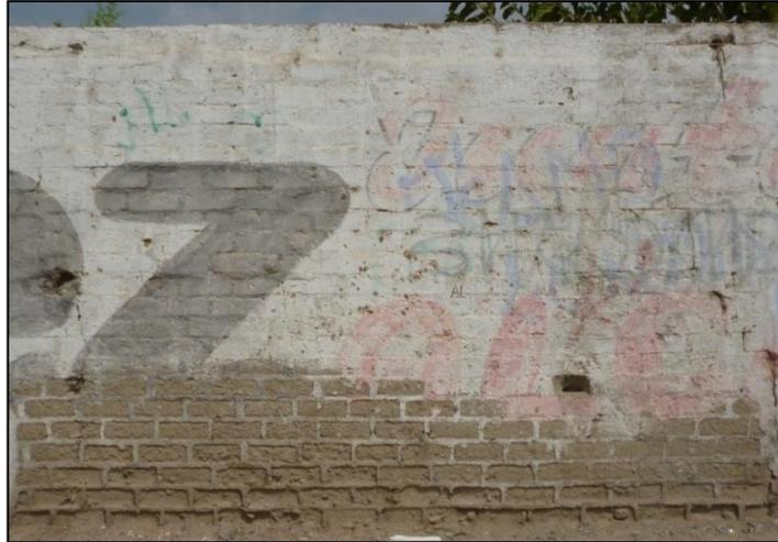
*Figura 30.* Erosión química en la parte inferior del muro por efecto de un suelo húmedo y salitroso.
