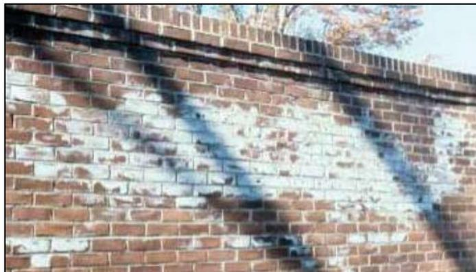
Figura 28. Presencia de eflorescencia en muros de albañilería.
