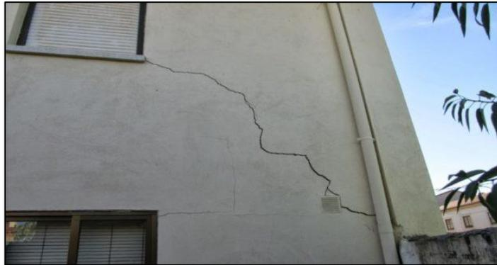
Figura 25. Ilustración de grieta en muro por causa de movimiento sísmico.
