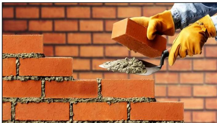
*Figura 21.* Ilustración del uso del mortero como adhesivo para pegar unidades de albañilería.
