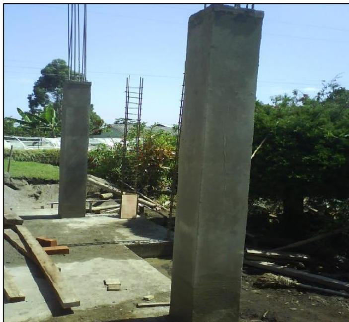
*Figura 13.* Ilustración de columna típica de concreto armado.
