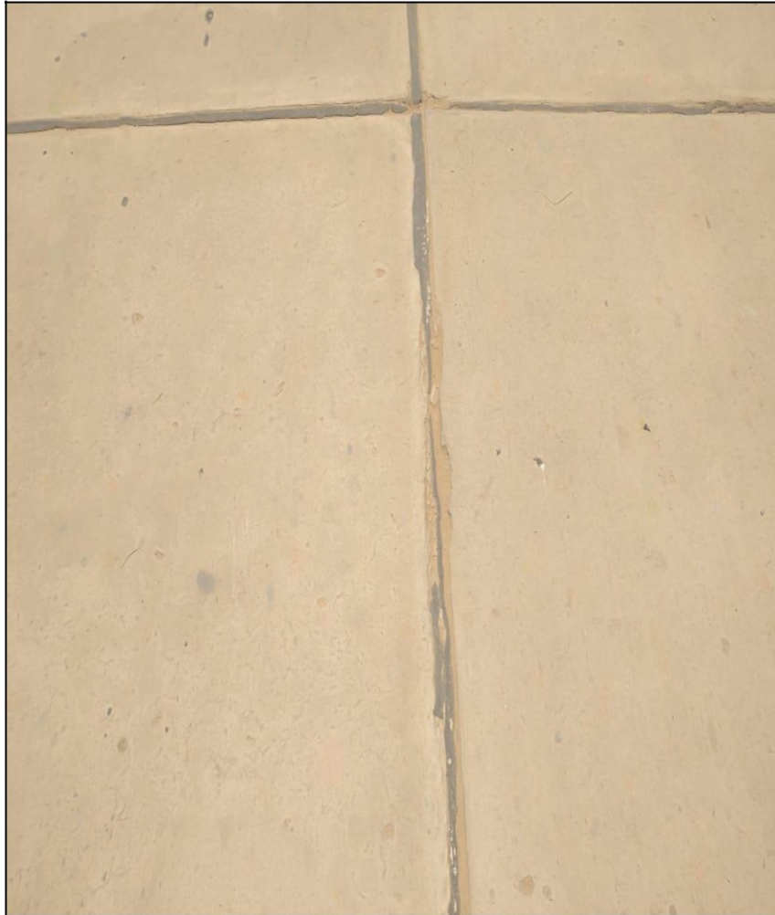
Figura 67: Daño del sello de la Junta severidad baja
