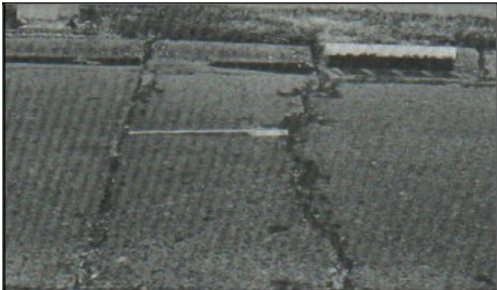
Figura 40: Punzonamiento de severidad baja
