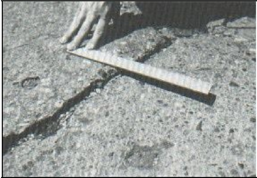
Figura 20: Escala de severidad media
