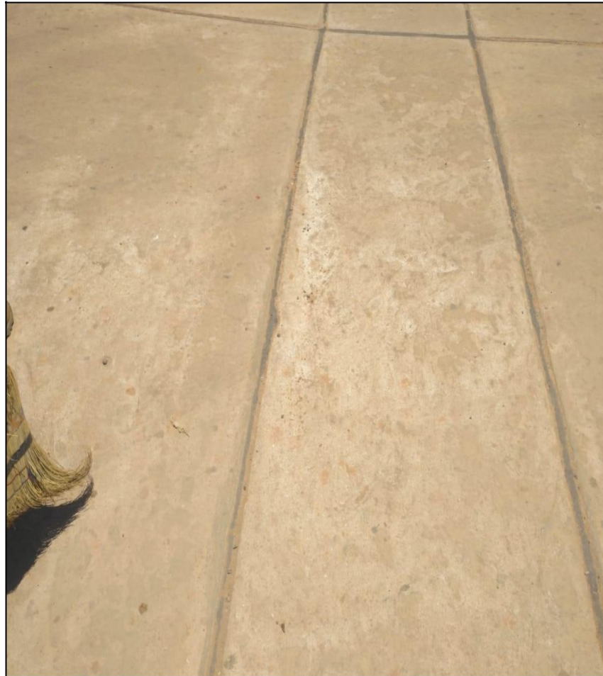
Figura 69: Parche Grande severidad baja
