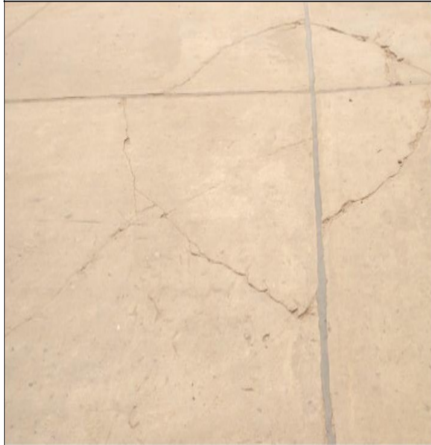
Figura 66: Grieta de esquina severidad baja
