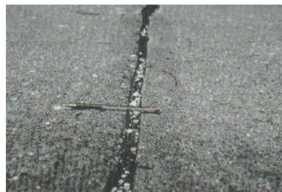
Figura: Sello de Junta de Alta Severidad. Fuente Manual del PCI (16)
