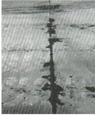
Figura: Bombeo (a)
