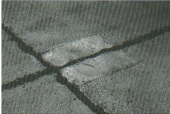
Figura: Parcheo Pequeño de Baja Severidad.
