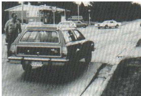
Figura: Blowup / Buckling de Alta Severidad.
