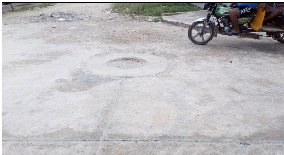
Fotografía 29: parche grande de alta severidad en UM - 11.
