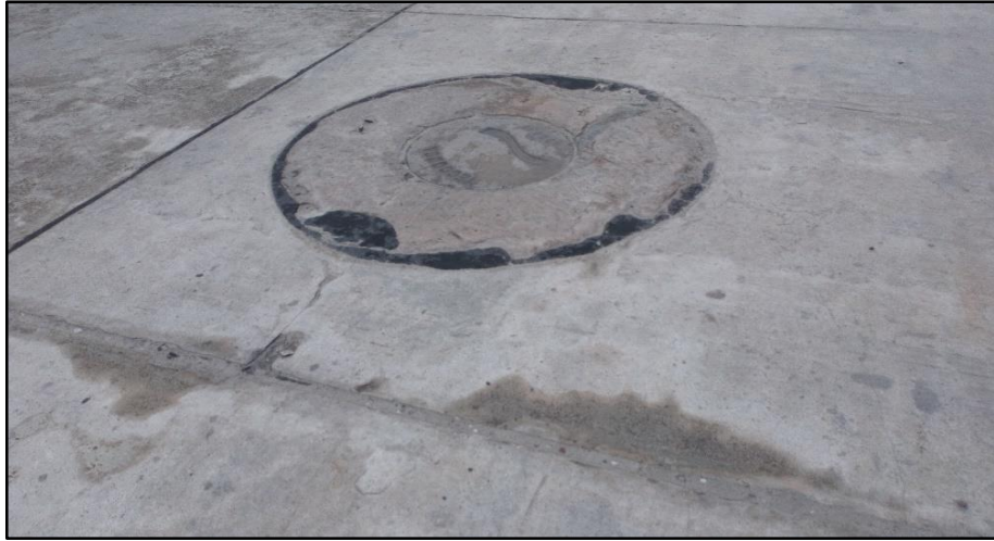
Fotografía 33: parche grande de severidad alta en UM - 13.
