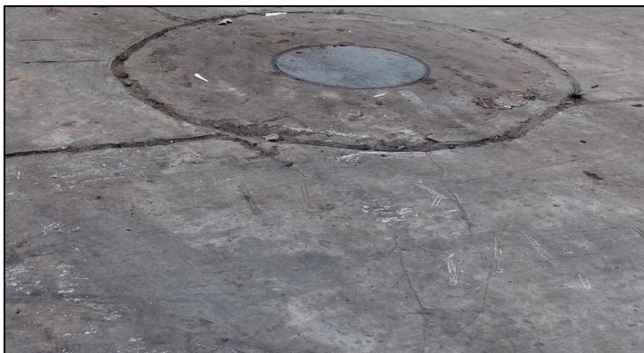
Fotografía 17: parche grande de severidad alta en UM - 03.
