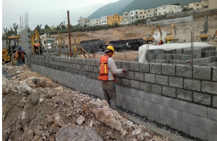
Figura 03. Albañilería armada
