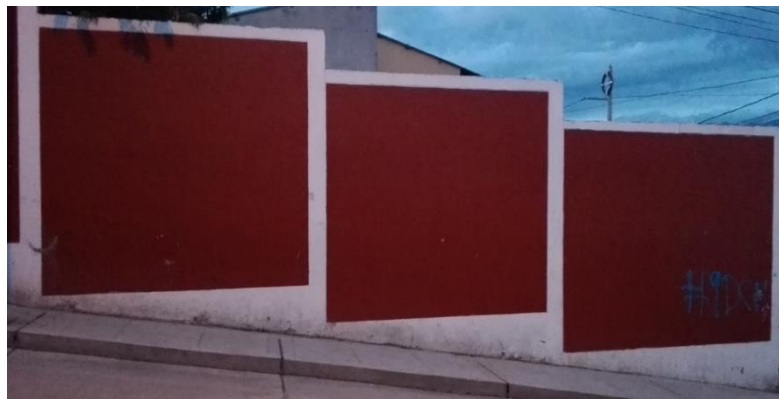
Figura 04. Estructura de albañilería confinada
