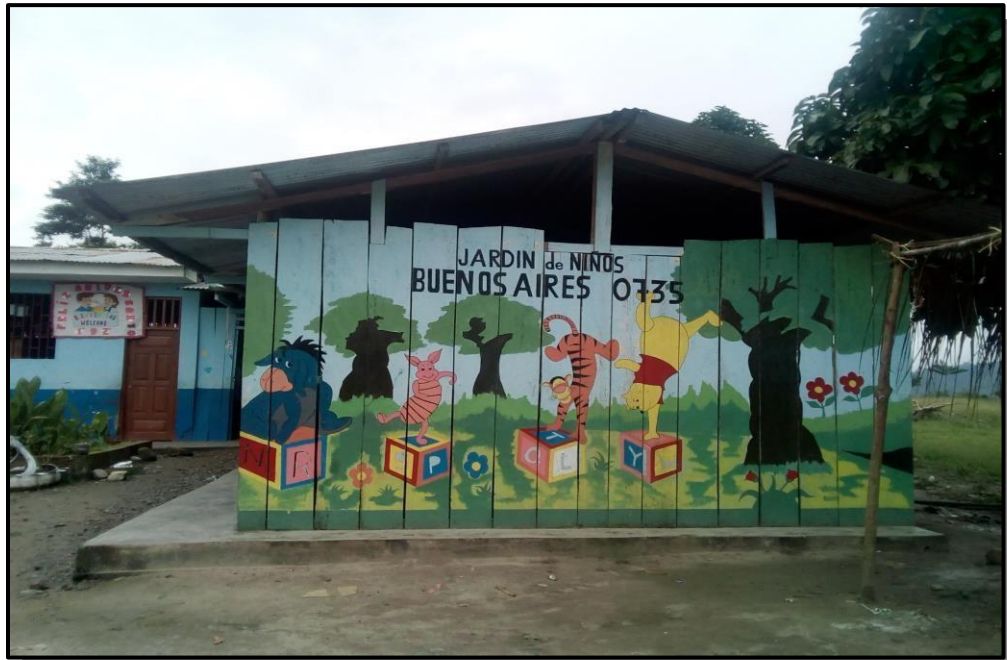
Foto N° 01: Fachada de la Institución Educativa N° 0735 de Buenos Aires.
