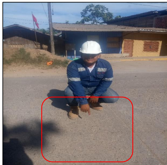
Fig. 44. Patología de Pulimiento de Agregados sin severidad, en la cuadra 1 de la Av. Santa Clara, Distrito de Manantay.
