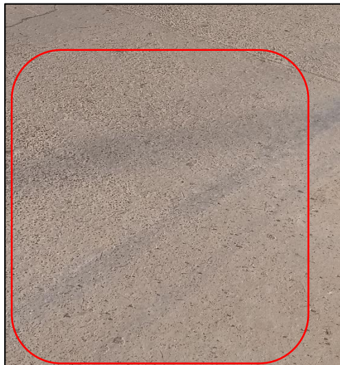
Fig. 53. Patología de Pulimiento de Agregados sin severidad, en la cuadra 4 de la Av. Santa Clara, Distrito de Manantay.
