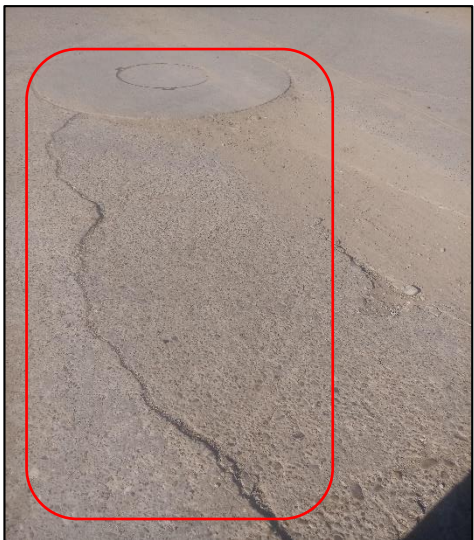
Fig. 46. Patología de Grieta Lineal con nivel de severidad alta, en la cuadra 2 de la Av. Santa Clara, Distrito de Manantay.
