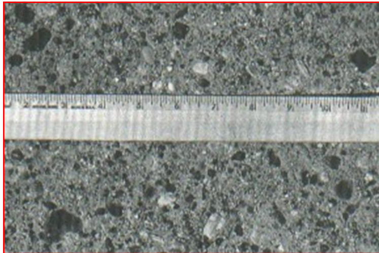
Figura 20. Pulimiento de agregados.
