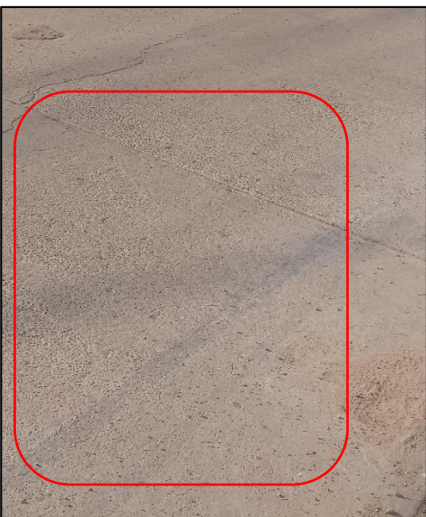
Fig. 47. Patología de Pulimiento de Agregados sin severidad, en la cuadra 2 de la Av. Santa Clara, Distrito de Manantay.
